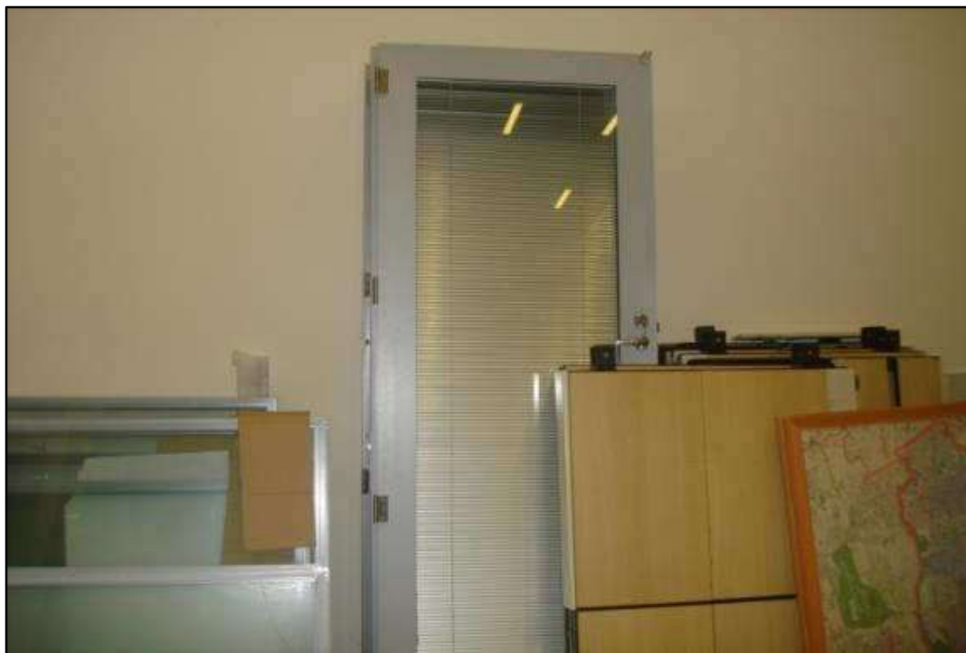
ITEM 1,020 - VISTA DA PORTA DE VIDRO
