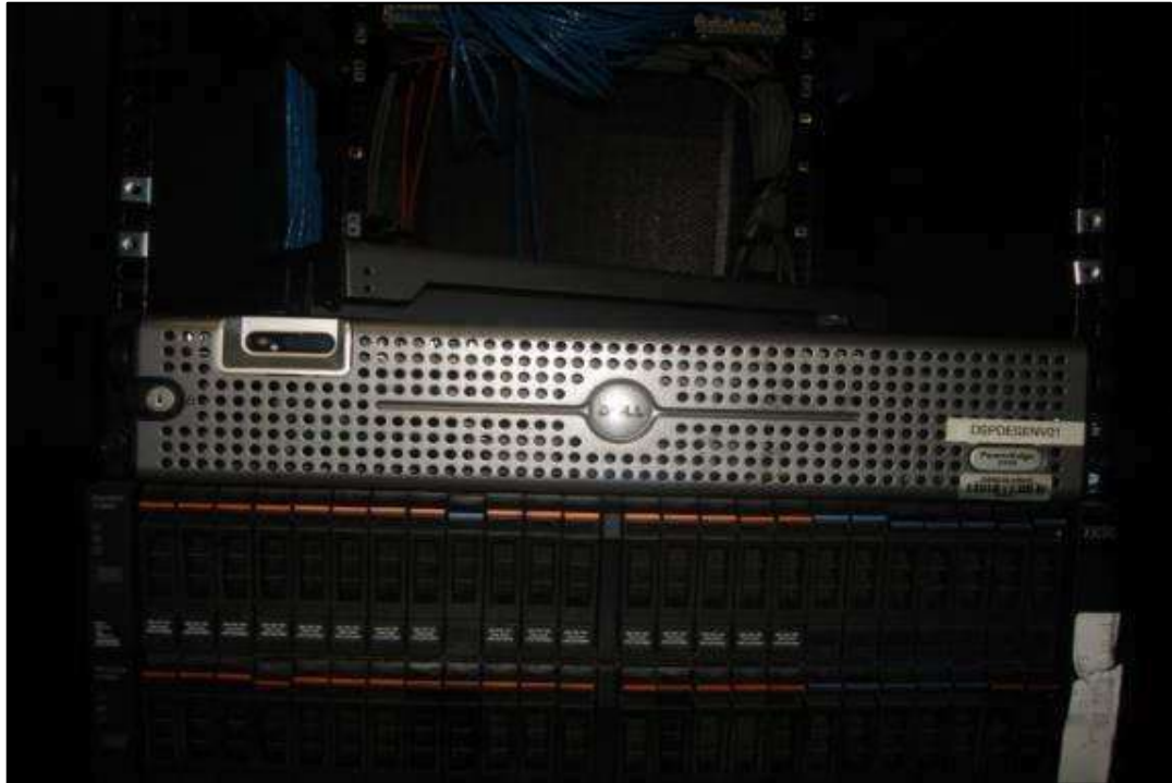
ITEM 1,355 - VISTA DO SERVIDOR DELL POWER EDGE 2950
