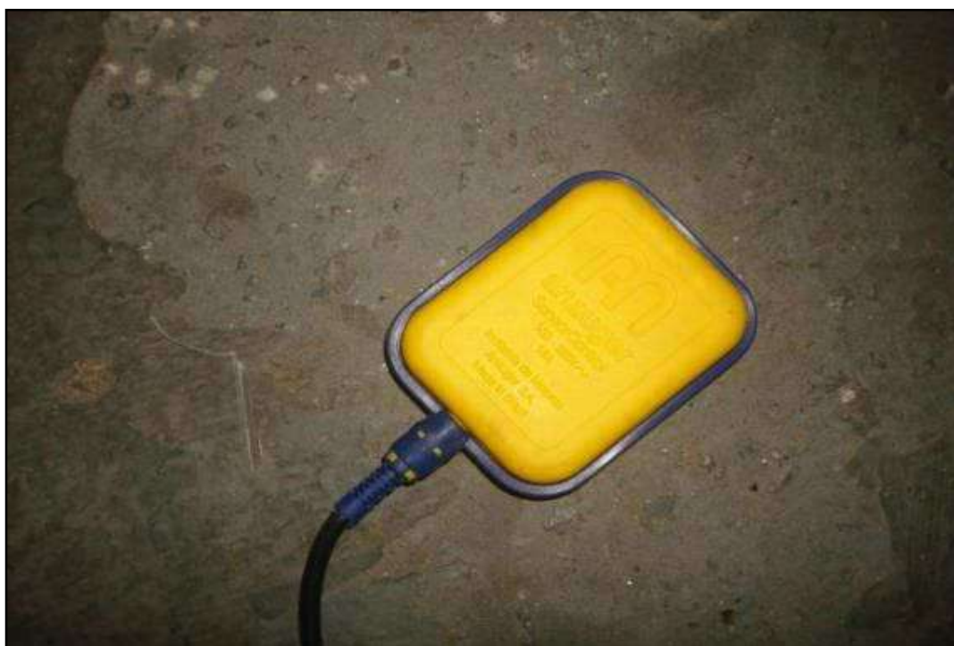
ITEM 1,835 - VISTA DA CHAVE BOIA DE NÍVEL
