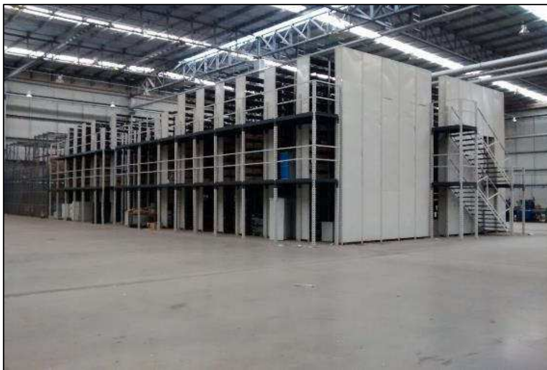
ITEM 2800 - VISTA DO MEZANINO COM ESTRUTURA METALICA DE 3 ANDARES E 4 ESCADAS FIXAS DE 11 DEGRAUS (DIMENSÕES DA ESTRUTURA: ALTURA 9M, LARGURA 13M E COMPRIMENTO 25M) COM DIVERSAS PRATELEIRAS MODULARES
