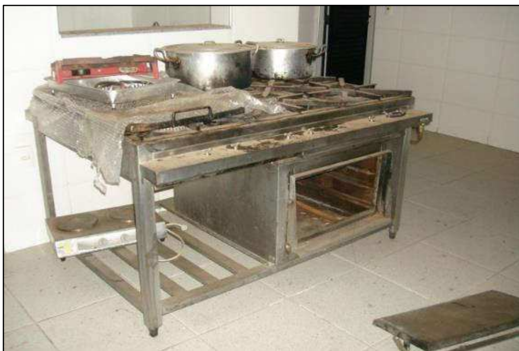
ITEM 0192 - VISTA DO FOGÃO INDUSTRIAL COM 6 BOCAS E FORNO
