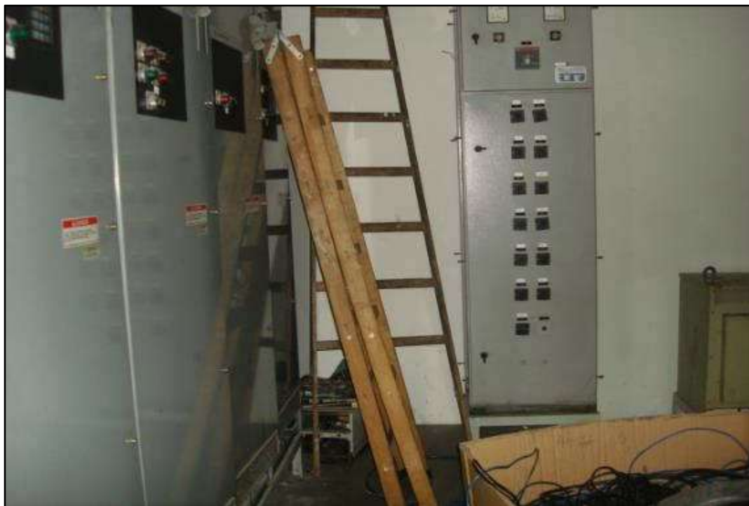
ITEM 2980 - VISTA DA ESCADA DE MADEIRA
