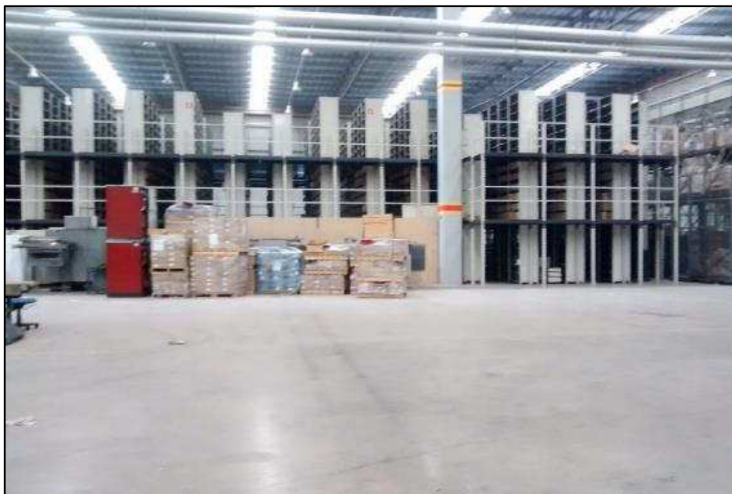
ITEM 2800 - VISTA DO MEZANINO COM ESTRUTURA METALICA DE 3 ANDARES E 4 ESCADAS FIXAS DE 11 DEGRAUS (DIMENSÕES DA ESTRUTURA: ALTURA 9M, LARGURA 13M E COMPRIMENTO 25M) COM DIVERSAS PRATELEIRAS MODULARES
