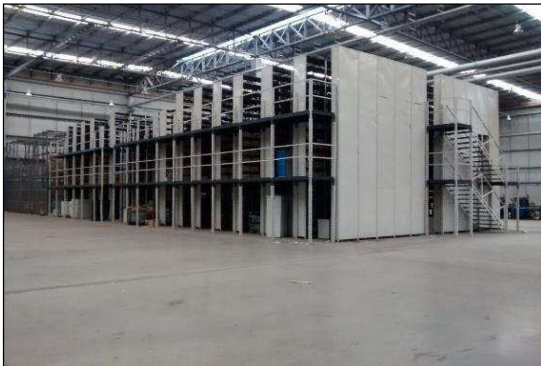
ITEM 2800 - VISTA DO MEZANINO COM ESTRUTURA METALICA DE 3 ANDARES (DIMENSÕES DA ESTRUTURA: ALTURA 9M, LARGURA 13M E COMPRIMENTO 25M) COM DIVERSAS PRATELEIRAS MODULARES
