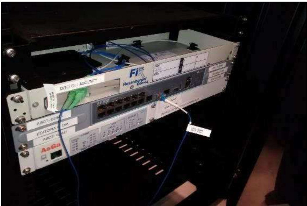
ITEM 1,066 AO 1,068 - VISTA DO ROSENBERGER DOMEX, DO JUNIPER EX2200-C E DO ASGA MMO2E FIBER OPTIC MULTIPLEXER
