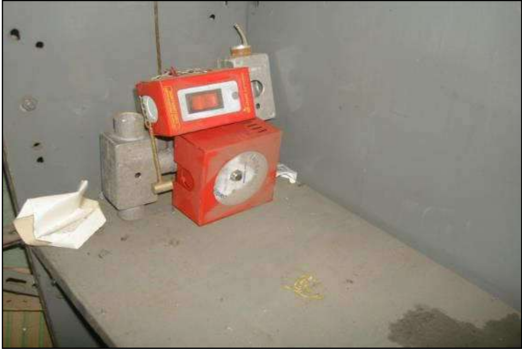
ITEM 1,681 - VISTA DA CAIXA SISTEMA DE INCÊNDIO
