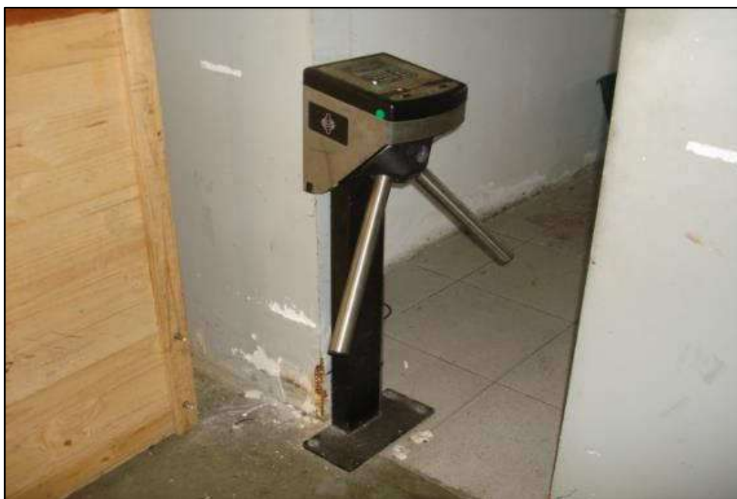
ITEM 0204 - VISTA DA CATRACA COM LEITOR DE PROXIMIDADE MARCA: DIMEP MOD: FANCY
