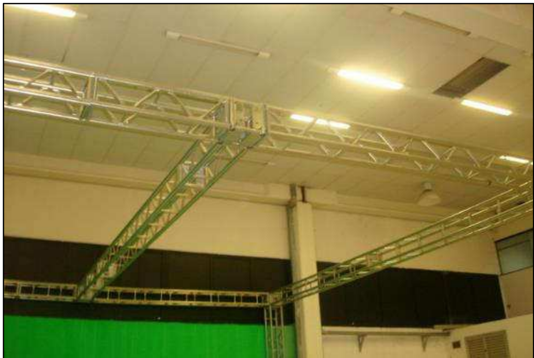
ITEM 1,003 - VISTA DA ESTRUTURA METÁLICA TRELIÇA (BOX TRUSS)
