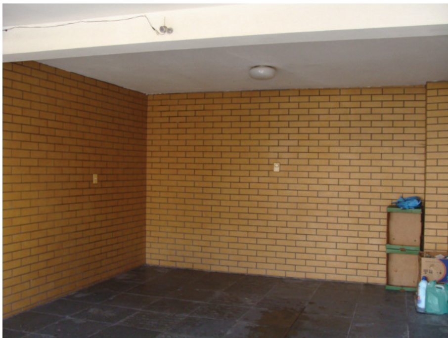
Foto 5. Vista da garagem.
