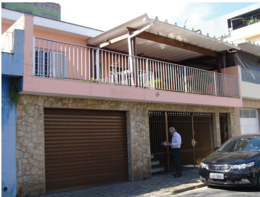
Foto 1. Vista da fachada frontal do imóvel.
