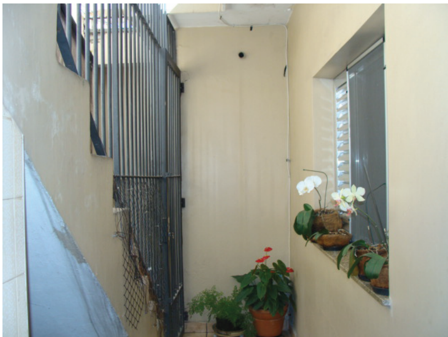
Foto 21. Vista parcial da escada de acesso a edícula.
