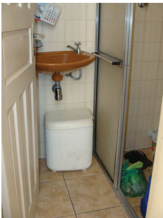
Foto 20. Vista parcial do banheiro externo.
