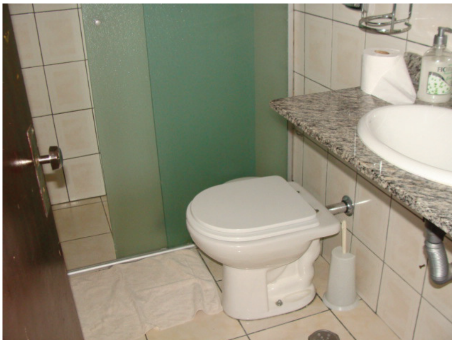
Foto 23. Vista parcial do banheiro.
