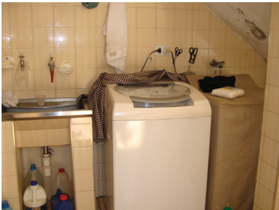
Foto 19. Vista parcial da área de serviço.
