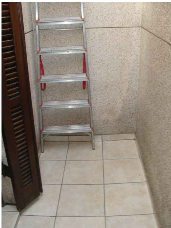
Foto 15. Vista parcial da área descoberta do dormitório 3.
