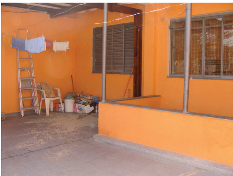
Foto 22. Vista da fachada da edícula.
