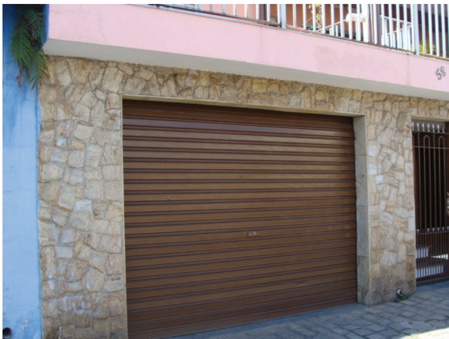
Foto 6. Vista da entrada do depósito.
