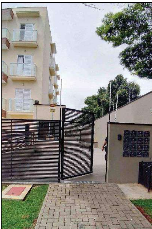
Imagem 06: Vista da portaria de acesso aos pedestres.
