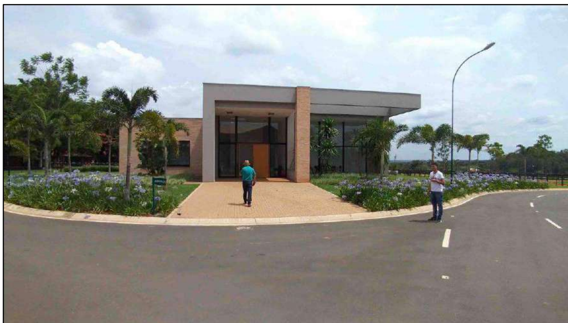
Imagem 04: Setor administrativo do Condomínio.
