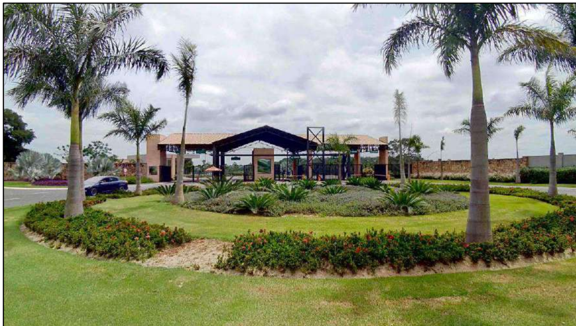
Imagem 03: Entrada do Condomínio Residencial Haras Patente, situado na Rodovia Porto Velho – Jaguariúna/SP.
