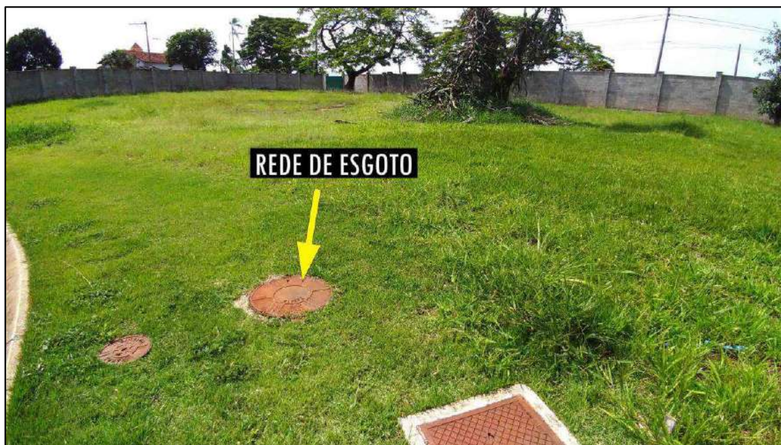
Imagem 21: Idem anterior, com rede de esgoto (estação própria do Condomínio).
