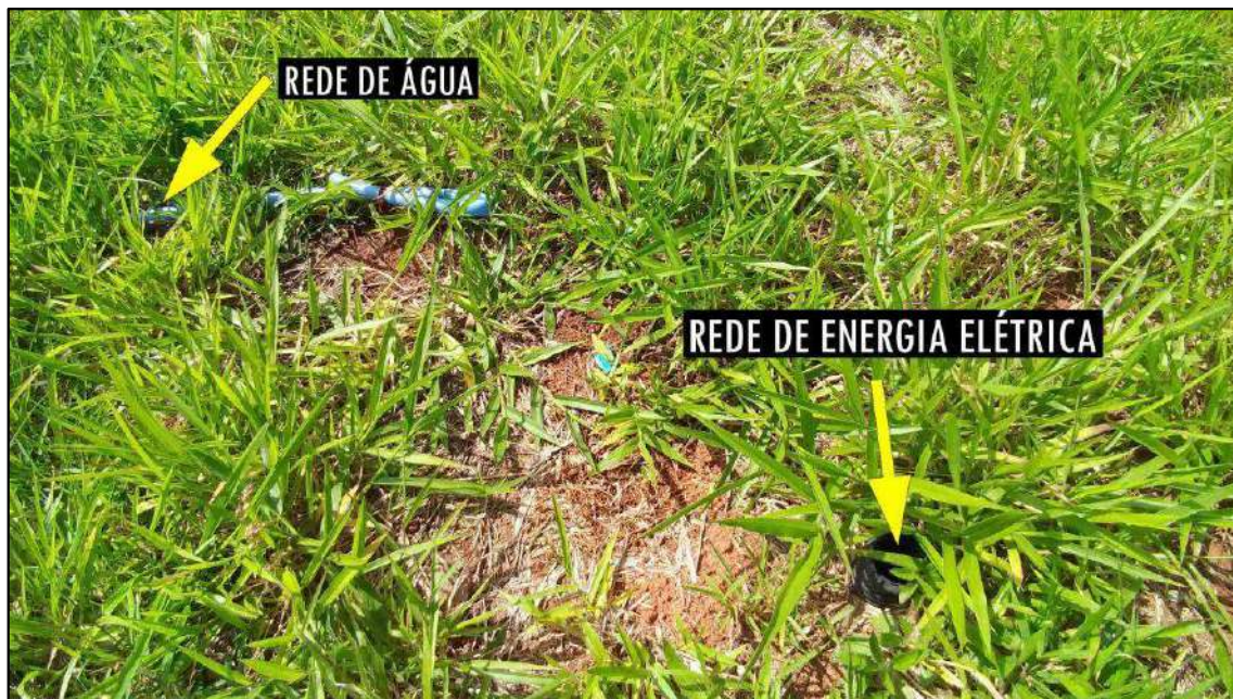
Imagem 20: Lote nº 12 / Quadra 02, dotado de todas infraestruturas básicas.
