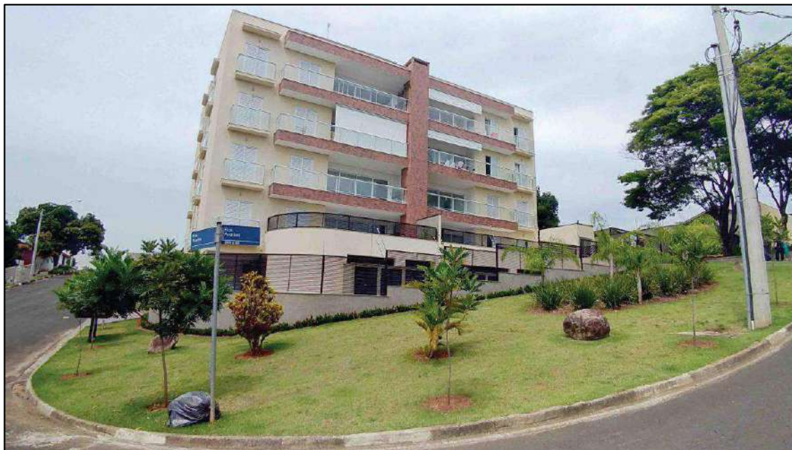
Imagem 04: Vista para a fachada do Condomínio Residencial Panorama.
