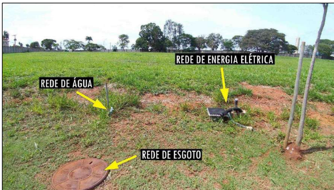
Imagem 13: Lote nº 12 / Quadra 04, dotado de todas infraestruturas básicas.
