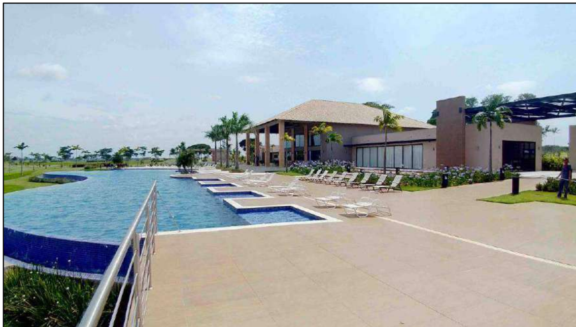
Imagem 34: Vista lateral esquerda da piscina.
