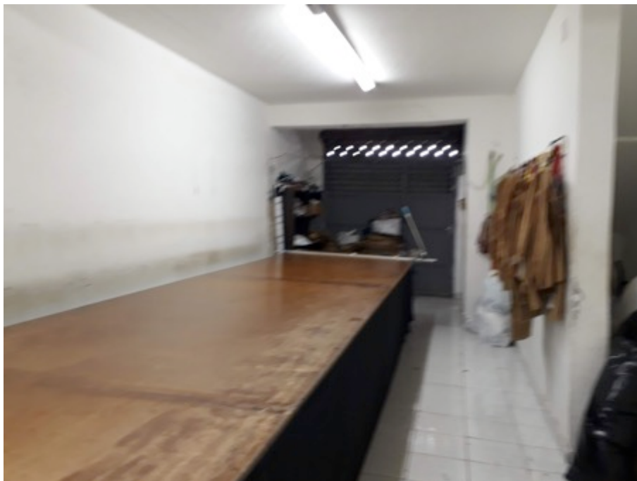
Fotos 5 e 6: Vista interna do piso térreo (garagem)
