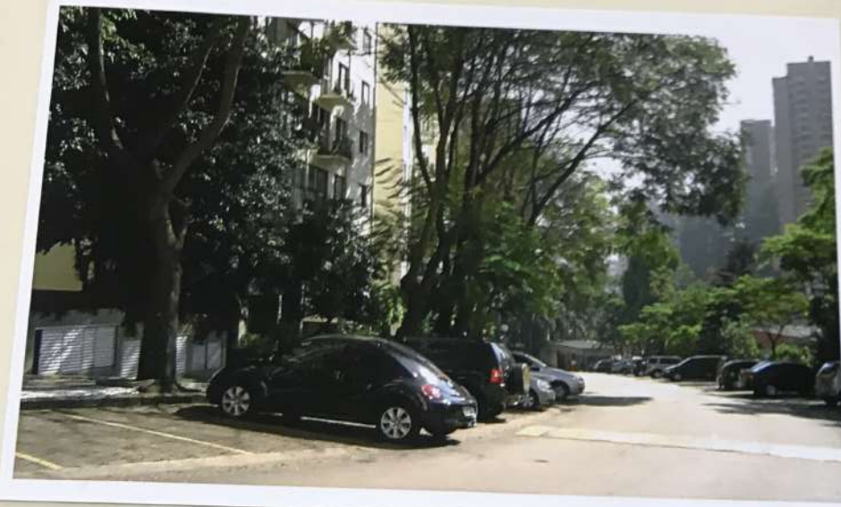
FOTO 07 - OUTRA VISTA DA VIA DE CIRCULAÇÃO INTERNA DO CONDOMÍNIO.
