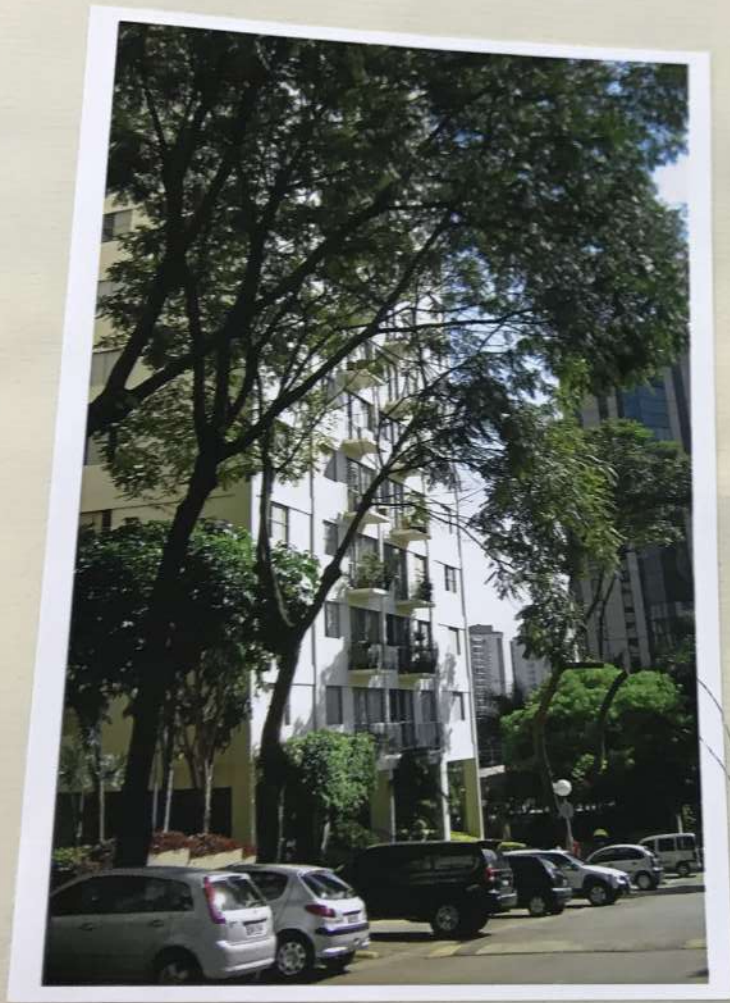
FOTO 02 - VISTA EXTERNA DO EDIFÍCIO YORK.
