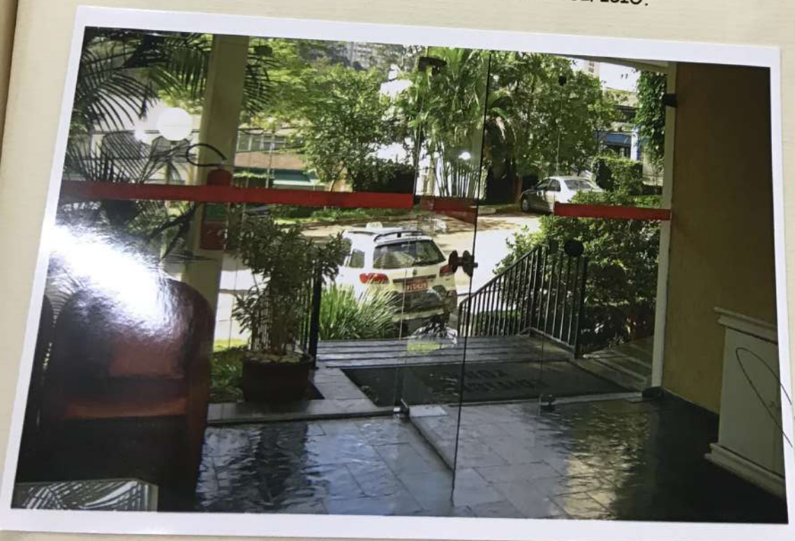
FOTO 13 - VISTA DO HALL SOCIAL DO EDIFÍCIO.
