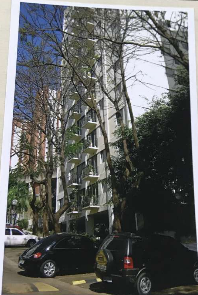
VISTA DA FACHADA DO EDIFÍCIO YORK
