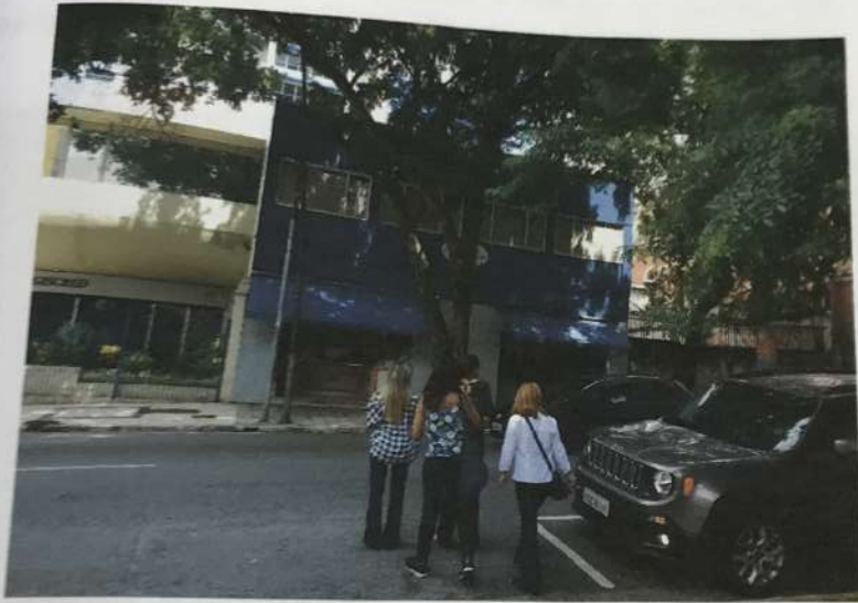
FOTO 1 e 2) – Vistas dos confrontantes dos edificios Condomínio em epigrafe.
