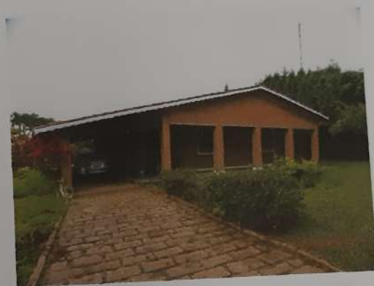
Figura 04: Vista da edificação principal.
