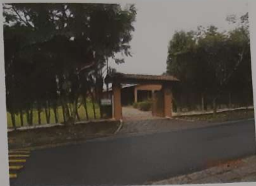
Figura 03: Vista da entrada do imóvel avaliando.
