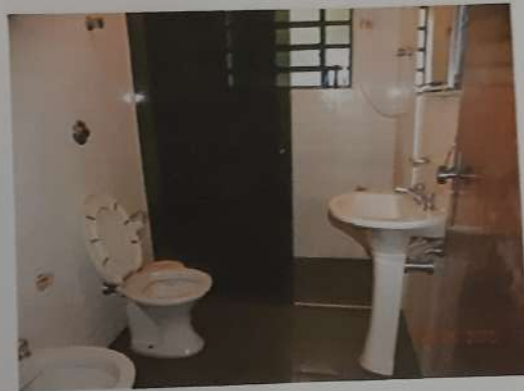
Figura 13: Banheiro da edificação principal.
