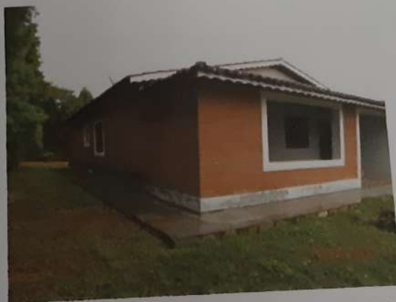
Figura 08: Vista geral da edificação principal.
