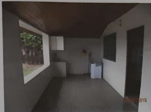
Figura 09: Área de serviço da edificação principal.
