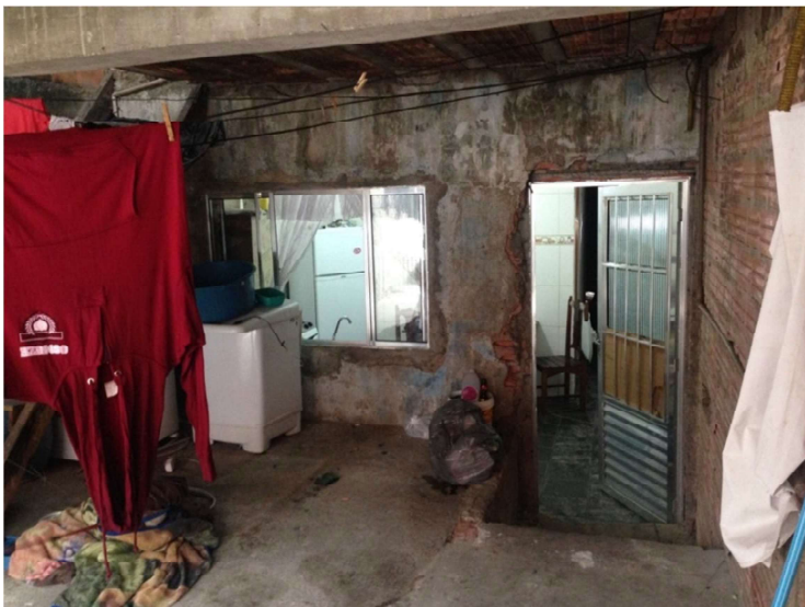
FOTO 04: Foto interna da garagem, mostrando a porta de entrada da cozinha e janela.
