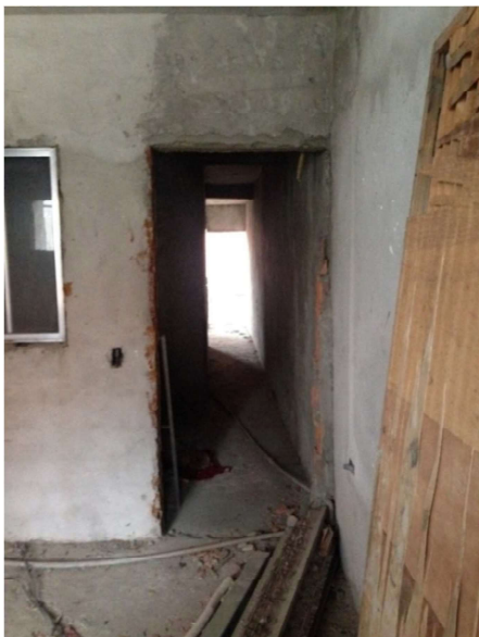
FOTO 15: Detalhe do corredor de circulação no pavimento superior.
