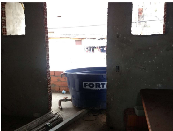
FOTO 16: Foto do dormitório da frente, com sacada para a rua, com a caixa d'água para instalar.
