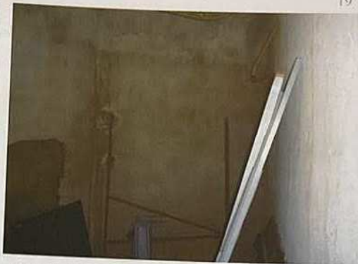
Características Internas do Imóvel Avaliando - Térreo.
