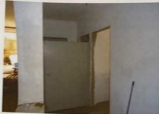
Características Internas do Imóvel Avaliando - Térreo.
