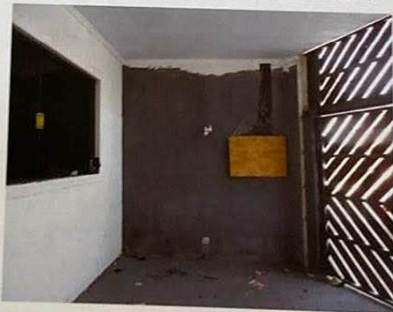
Características Internas do Imóvel Avaliando - Térreo.
