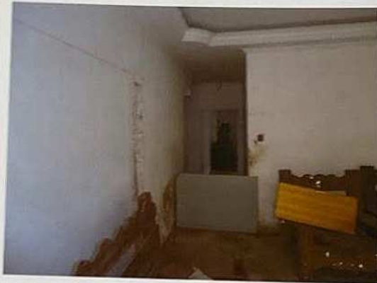
Características Internas do Imóvel Avaliando - Térreo.
