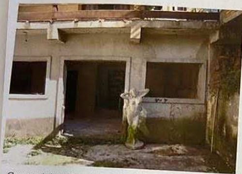
Características Externas do Imóvel Avaliando - Térreo.
