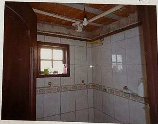
Características Internas do Imóvel Avaliando - 2º pav.
