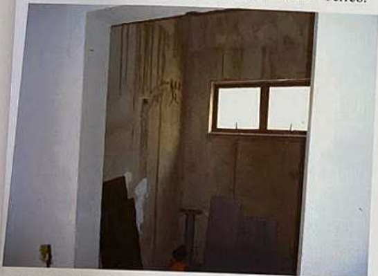
Características Internas do Imóvel Avaliando - Térreo.
