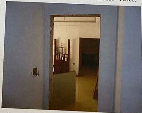
Características Internas do Imóvel Avaliando - Térreo.
