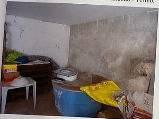
Características Internas do Imóvel Avaliando - Térreo.
