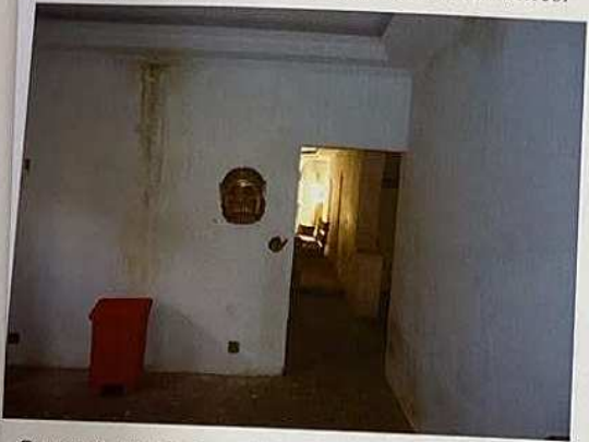
Características Internas do Imóvel Avaliando - Térreo.
