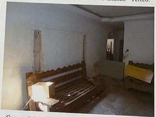
Características Internas do Imóvel Avaliando - Térreo.
