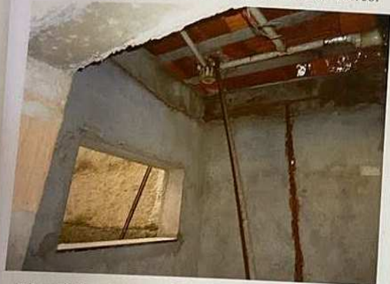
Características Internas do Imóvel Avaliando - Térreo.
