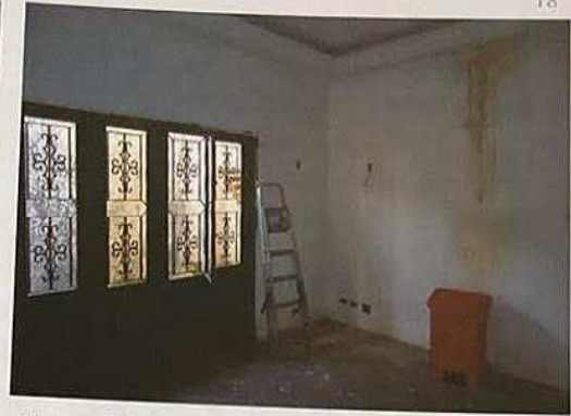
Características Internas do Imóvel Avaliando - Térreo.
