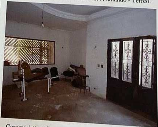
Características Internas do Imóvel Avaliando - Térreo.
