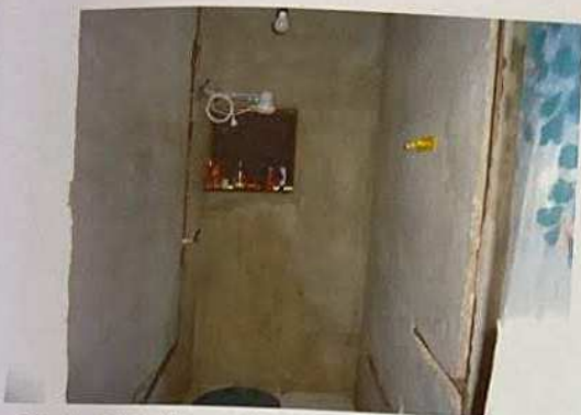
Características Internas do Imóvel Avaliando - Térreo.
