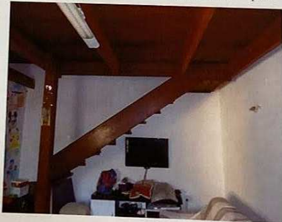
Características Internas do Imóvel Avaliando - 2º pav.
