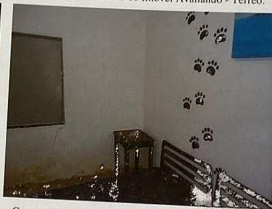
Características Internas do Imóvel Avaliando - Térreo.
