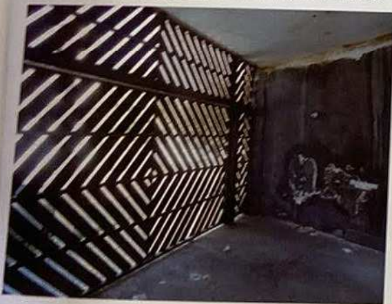
Características Internas do Imóvel Avaliando - Térreo.
