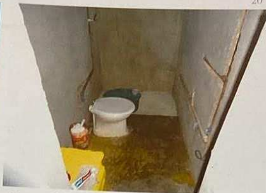
Características Internas do Imóvel Avaliando - Térreo.
