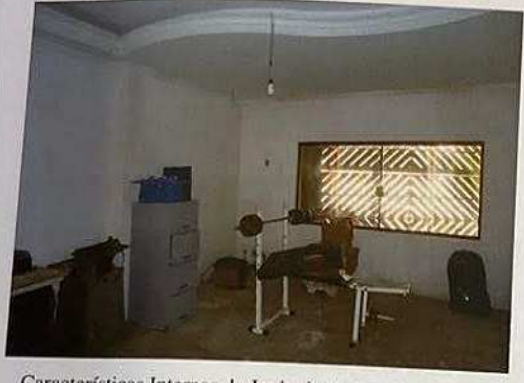
Características Internas do Imóvel Avaliando - Térreo.
