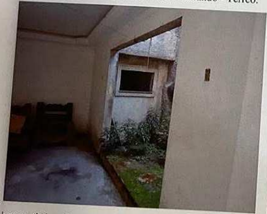
Características Internas do Imóvel Avaliando - Térreo.
