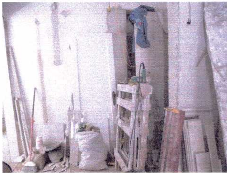
FOTO 08: - Vista da reforma do imóvel similar (nº71).
