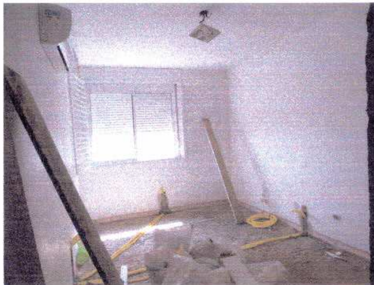
FOTO 05:- Vista do outro dormitório do imóvel similar (nº71).
