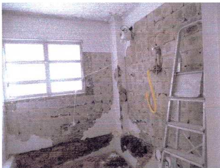
FOTO 03:- Vista do banheiro do imóvel similar (nº71).
