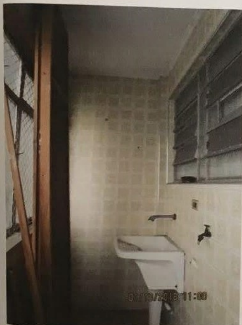
Área de serviço com tanque
