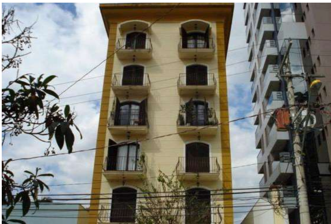
FOTO Nº 1 – Vista da Fachada do Condomínio Edifício Almirante
