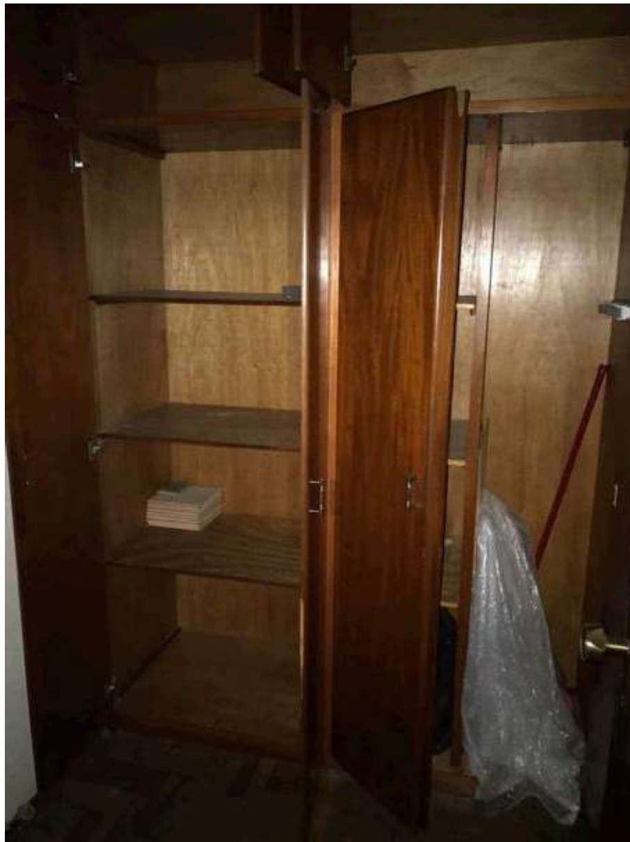
FOTO nº 11 Vista do armário no quarto de empregada.
