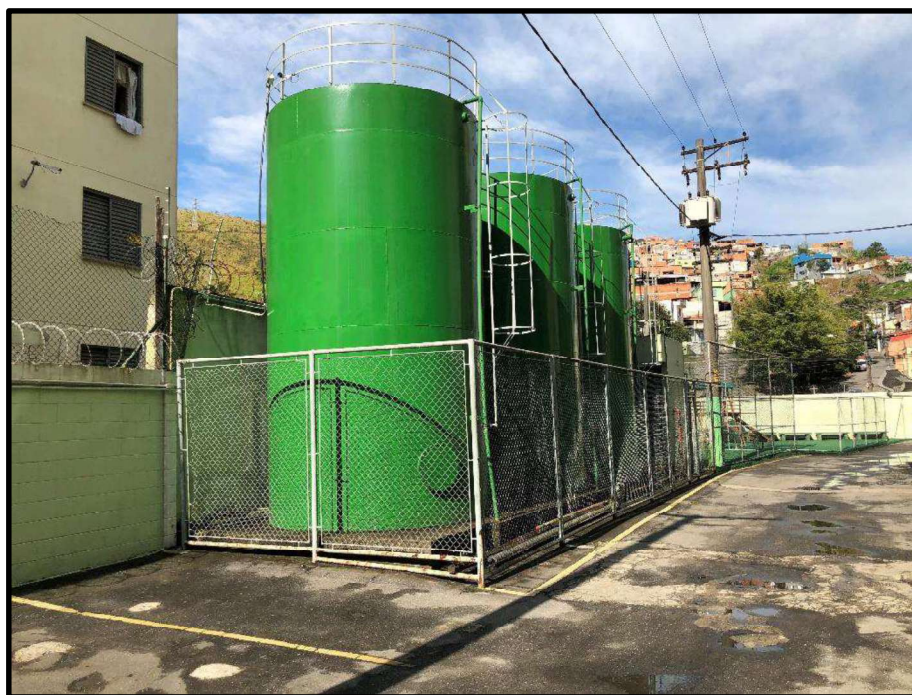
Foto 13 – Caixas d'água – Conjunto Residencial Athenas II
