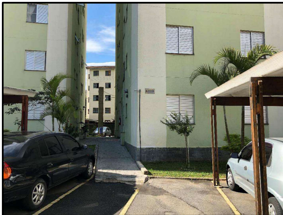
Foto 3 – Conjunto Residencial Athenas II – entrada do Bloco 4
