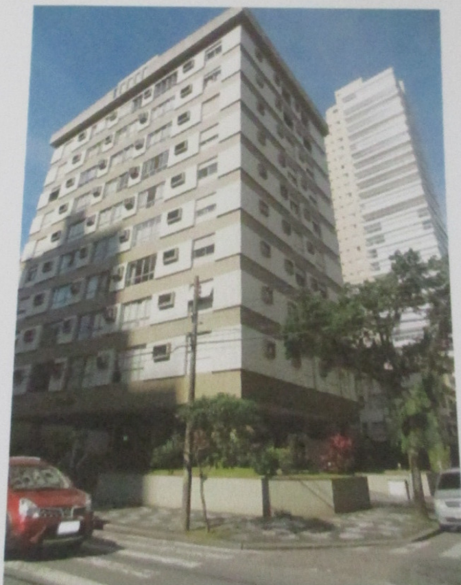
Foto 14 - Vista geral do Ed. Velazquez
