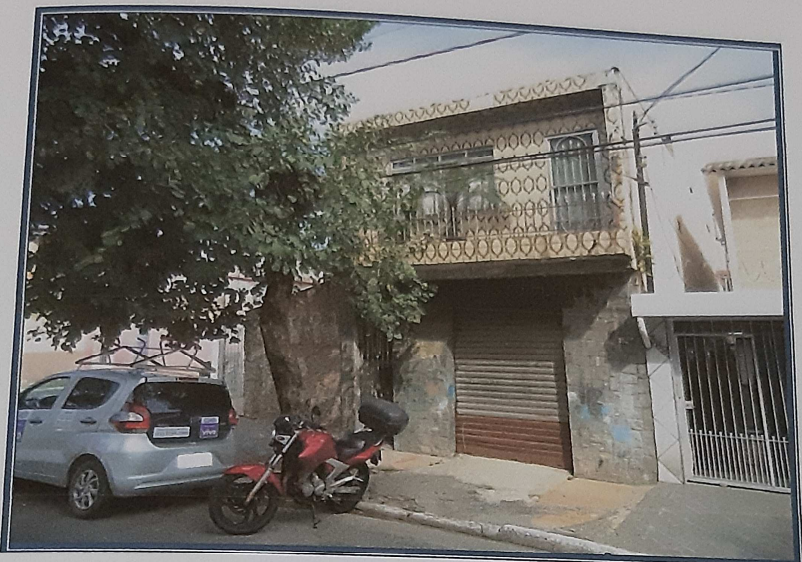
Vista da frente do imóvel avaliando.
