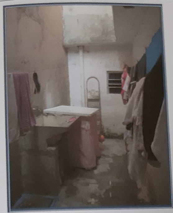
Casa 1 – térreo: Área de serviço.
