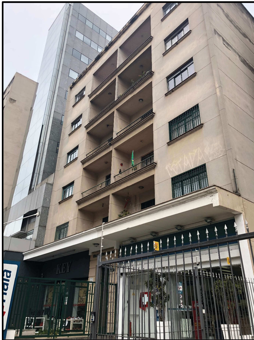
Foto 1: Fachada do Edifício Castro Prado
