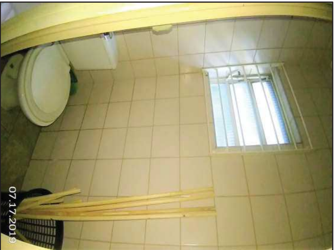
Vista do sanitário 1
