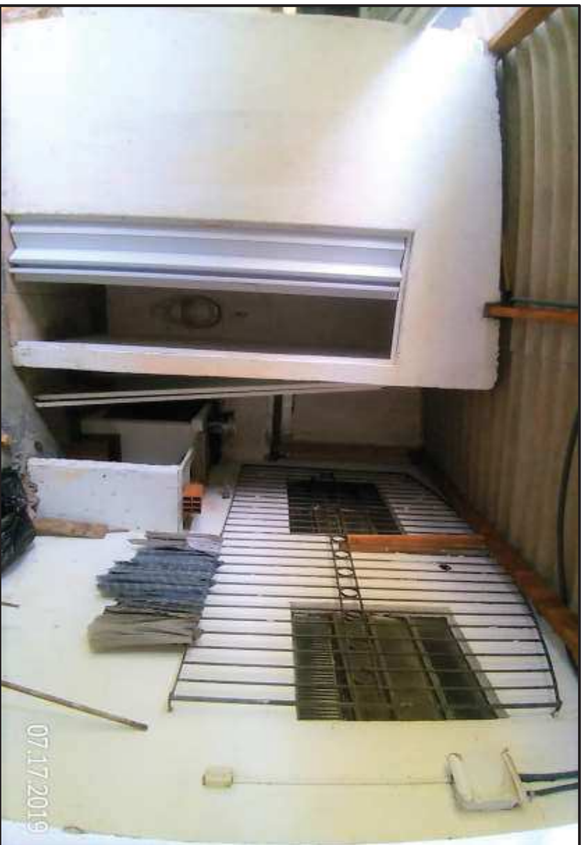
Vista 2 do pátio coberto
