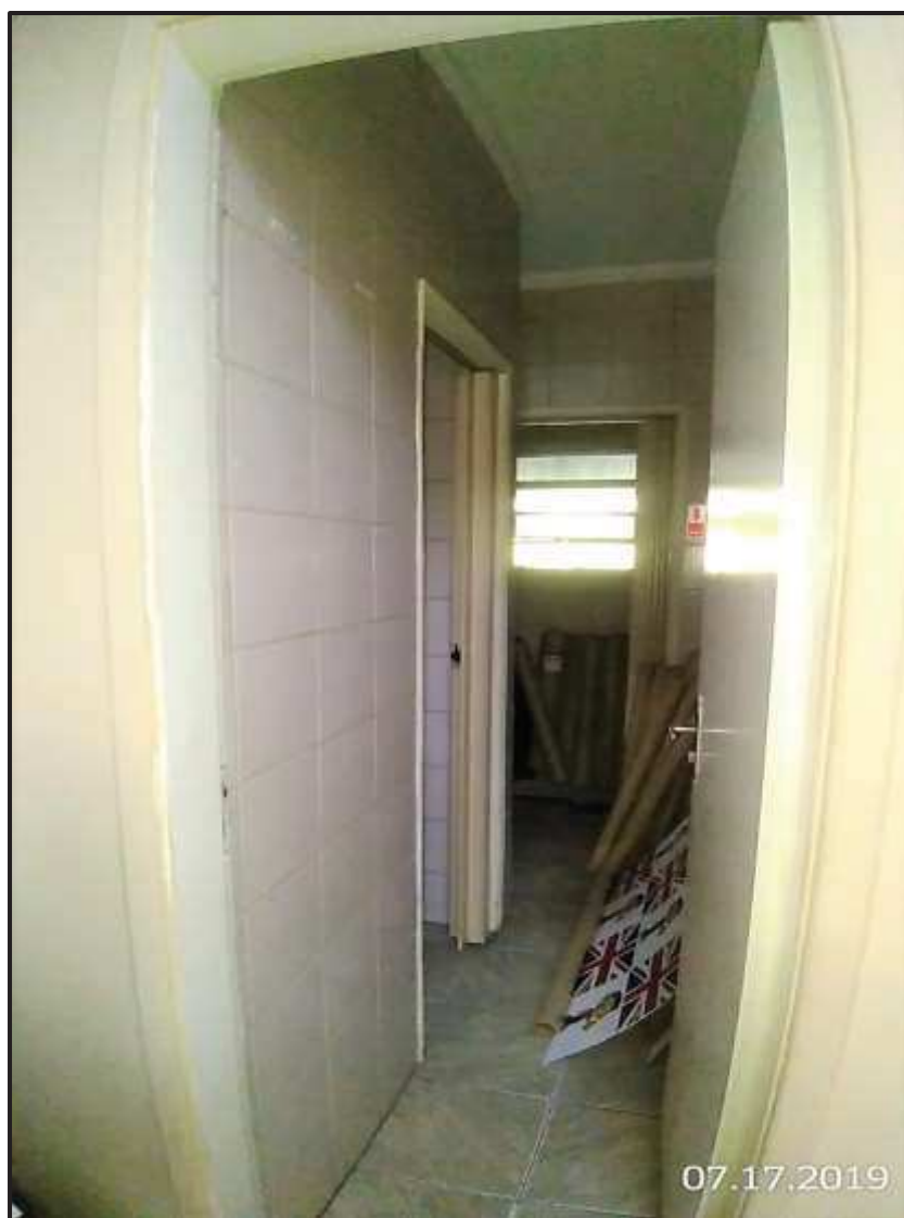
Vista do conjunto de sanitários
