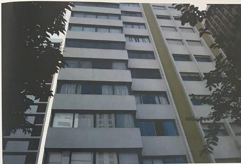
FOTO Nº 01 – Vista da fachada do Edifício Paola.
