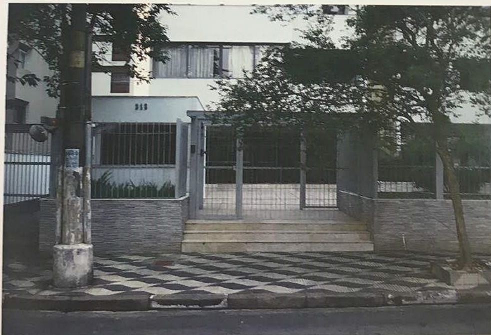
FOTO Nº 04 – Vista da portaria no Edifício Paola.
