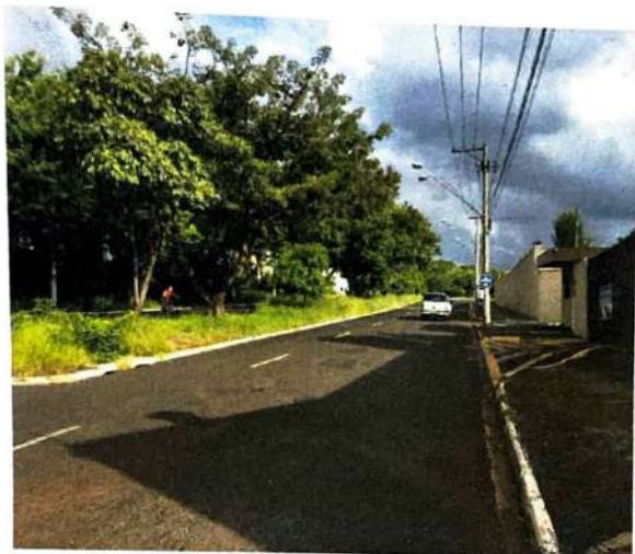
Foto 1 – Avenida Patriarca junto ao Condomínio Residencial Guedes e Tonani
