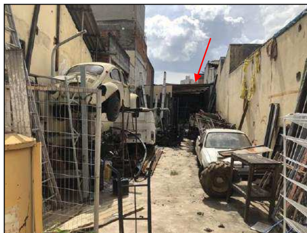
FOTO 02 – VISTA DA COBERTURA 01
