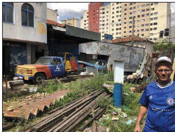
FOTO 04 – VISTA DA EDIFICAÇÃO ASSOBRADA E DA COBERTURA 02
