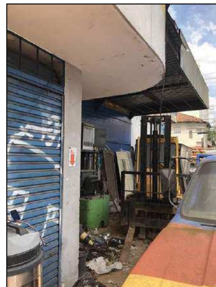
FOTO 06 – VISTA DA COBERTURA 02
