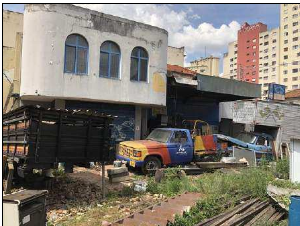
FOTO 03 – VISTA DA EDIFICAÇÃO ASSOBRADA E DA COBERTURA 02
