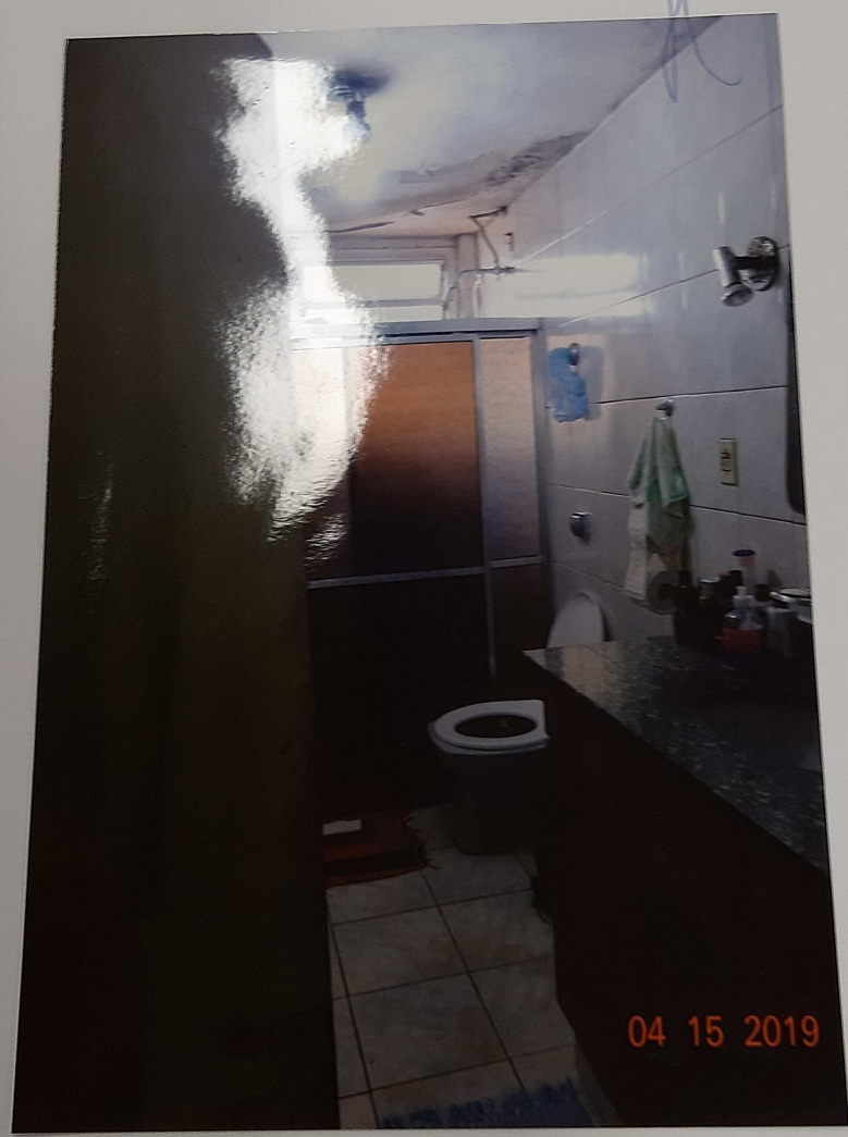
VISTA DO BANHEIRO SOCIAL.
