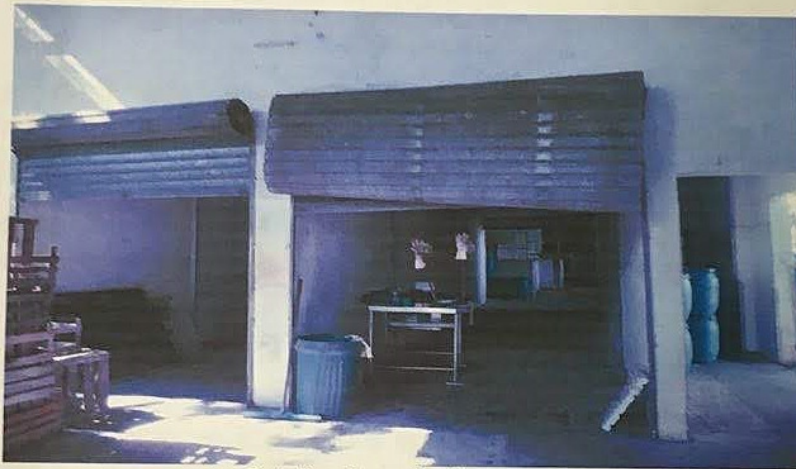
Detalhe da porta de acesso
