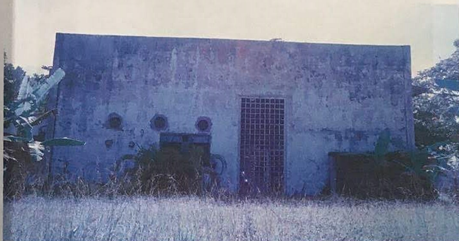
Vista Frontal do Galpão
