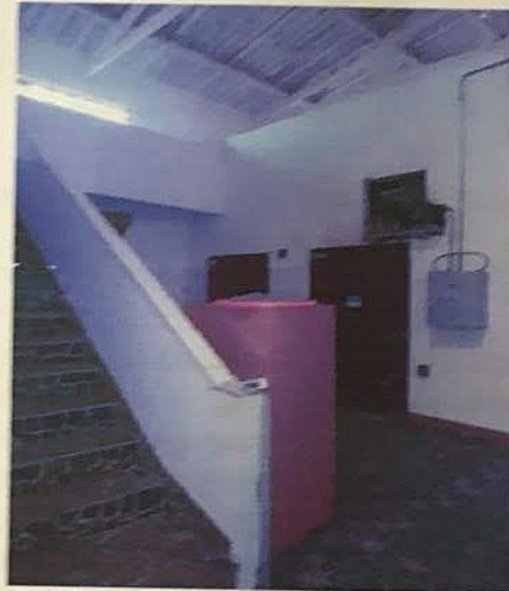
Vista acesso ao Mezanino
