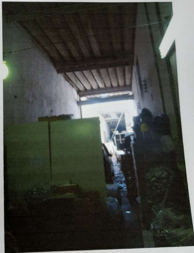
Foto 05: Outra vista interna do imóvel do Embargante (faixa de 2,00 da esquerda para a direita), em direção aos fundos.
