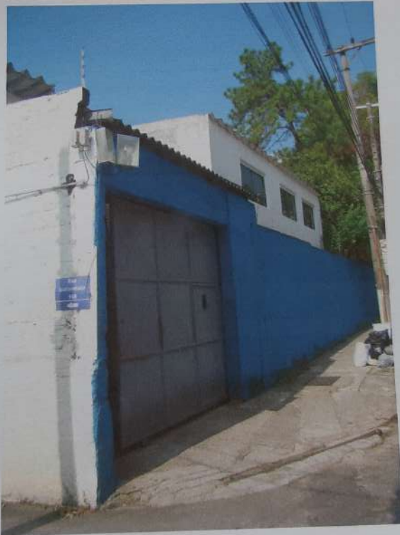
Foto 06: Vista das testadas dos terrenos do Embargante e da Massa Falida.
