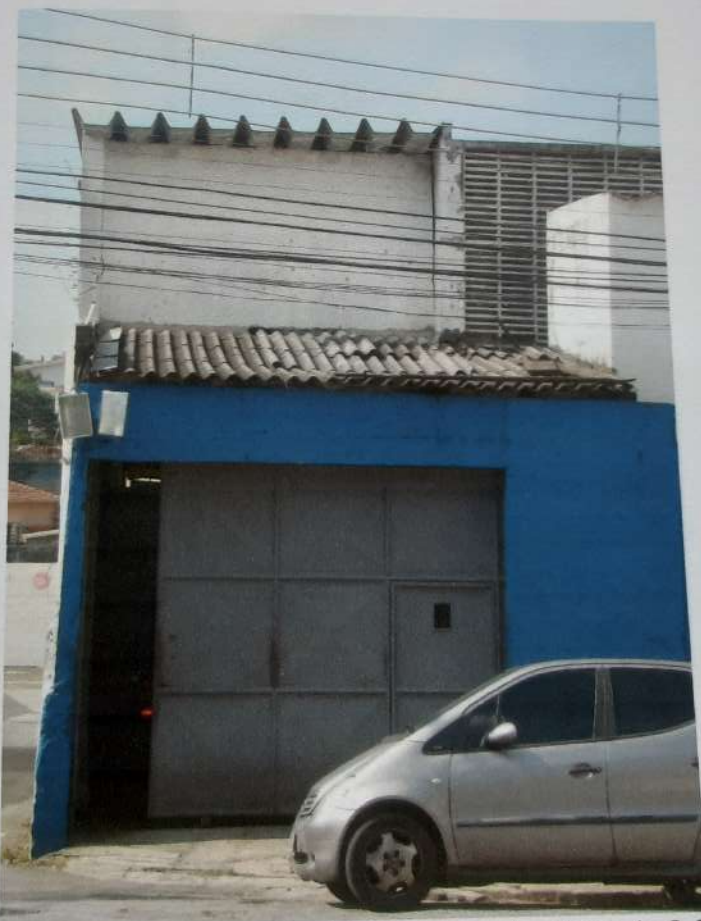
Foto 03: Vista da testada do imóvel do Embargante, faixa de 2,00m a partir da divisa à esquerda da fotografia.
