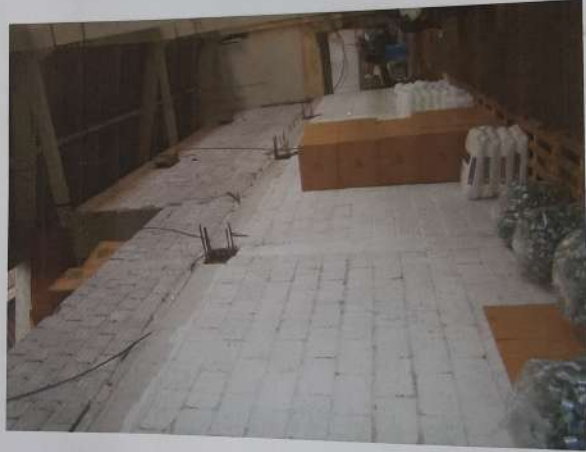
Foto 42: Vista parcial de um dos acessos ao galpão.
