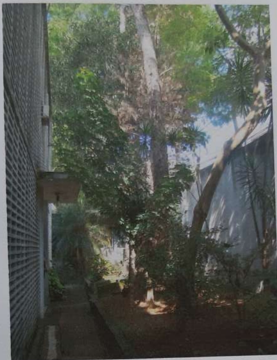
Foto 17: Outra vista do recuo frontal, destacando à esquerda da fotografia a entrada do prédio administrativo – construção original.
