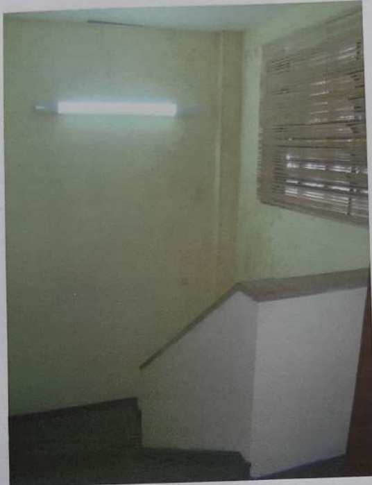
Foto 21: Vista do hall de escada de ligação entre os pavimentos do prédio administrativo através da recepção.
