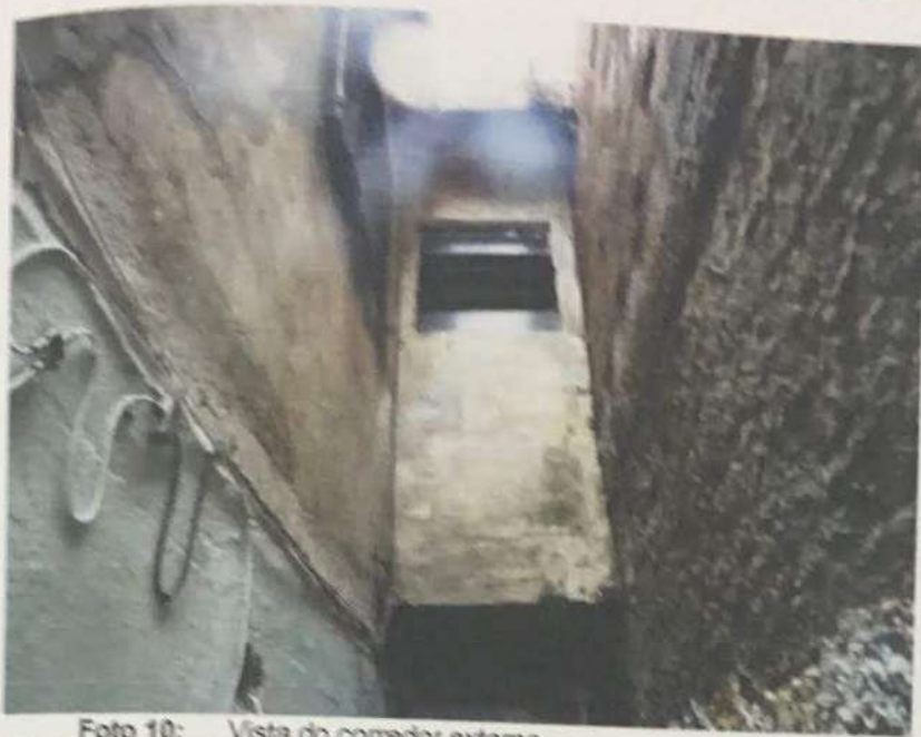
Foto 10: Vista do corredor externo.
