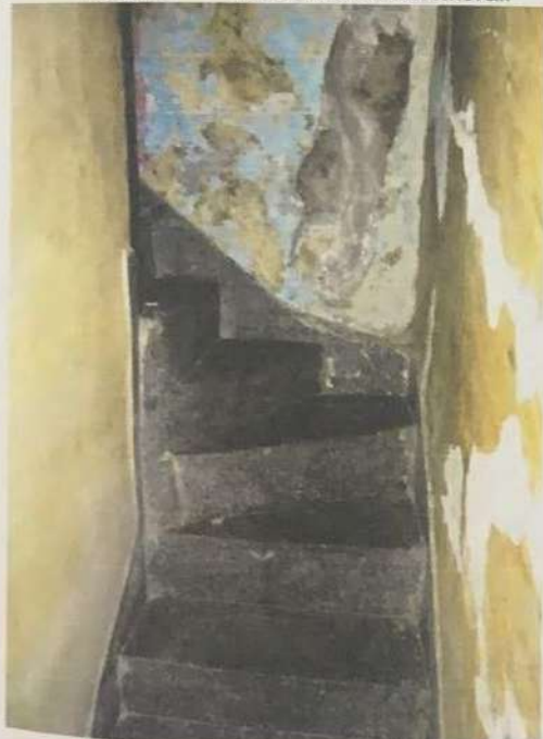
Foto 3: Vista da escada de acesso ao piso superior.
