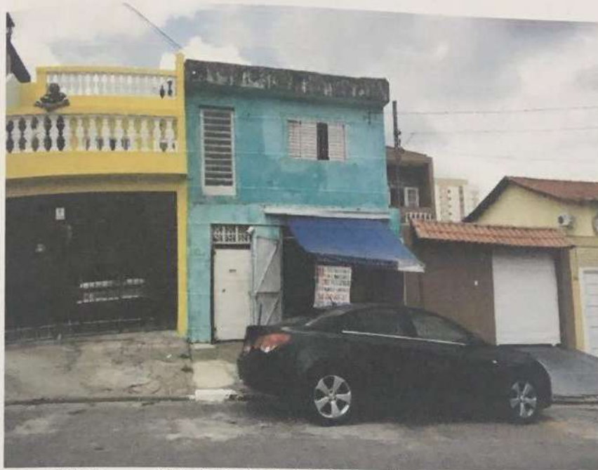
Foto 1: Vista da fachada do imóvel avaliando.
