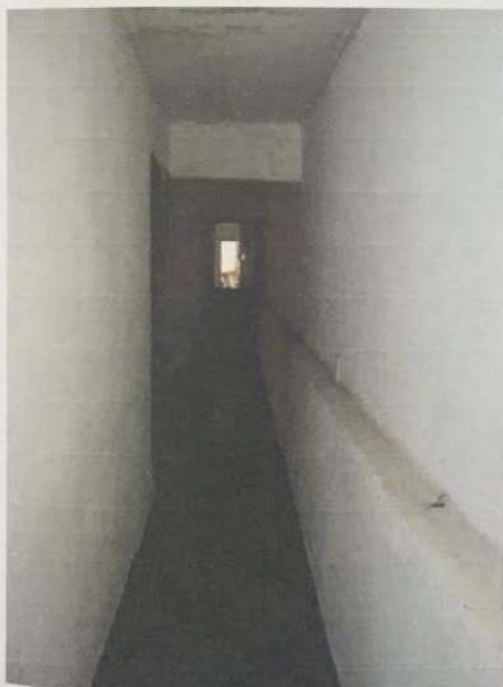
Foto 9: Piso superior - corredor de circulação.
