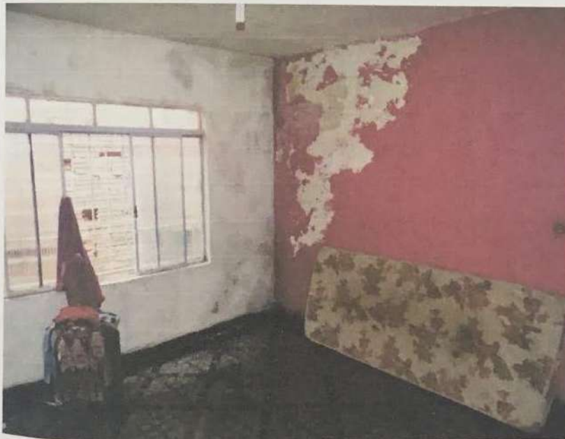
Foto 7: Piso superior - dormitório.
