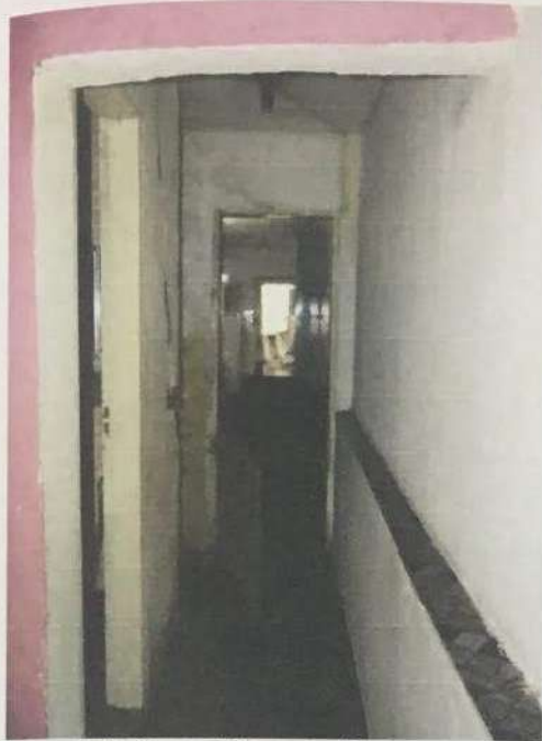
Foto 6: Piso superior - corredor de circulação.
