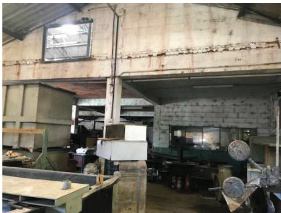
Foto 04 - Ligação interna entre o galpão anexo e o principal.
