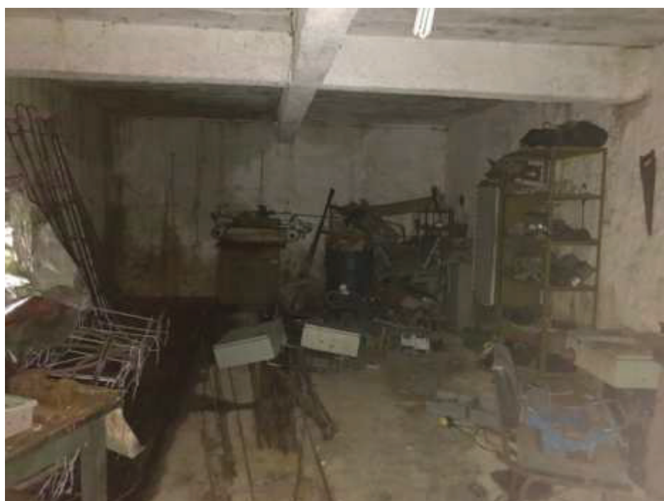
Foto 10 - Vista interna do almoxarifado, junto ao térreo do galpão principal.
