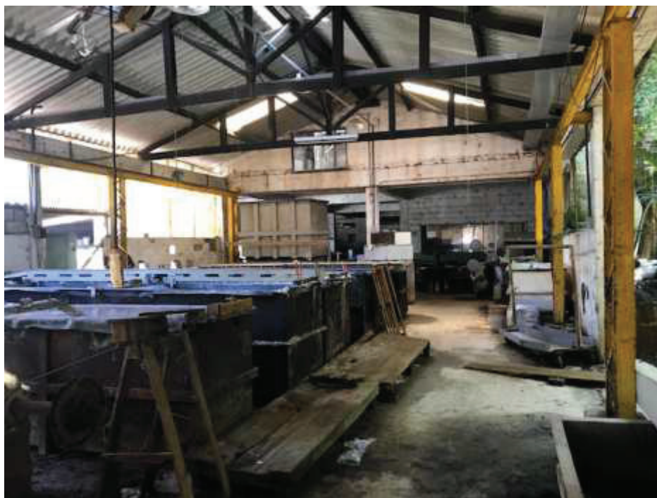
Foto 03 - Vista interna do galpão anexo.
