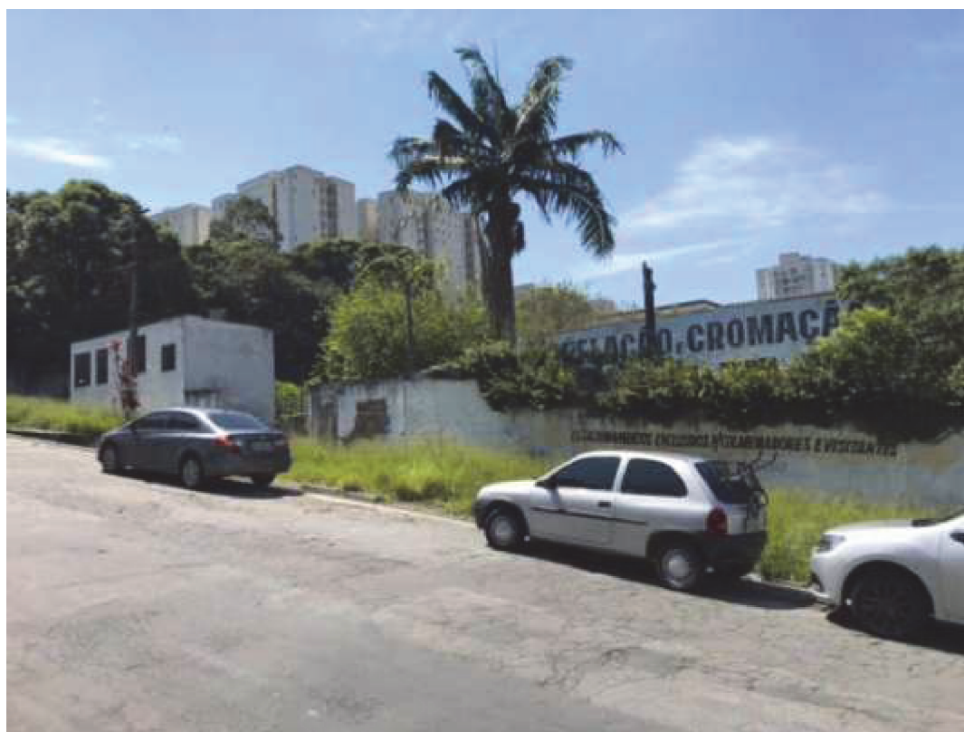
Identificação do imóvel localizado na Rua Oneda nº 981, Bairro Planalto, São Bernardo do Campo/SP
