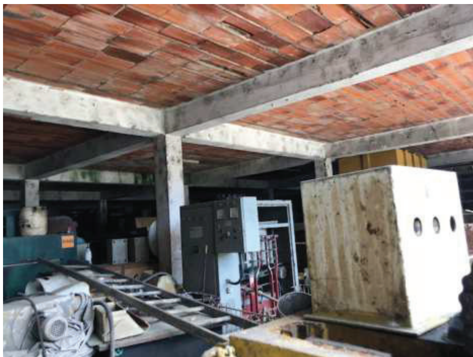
Foto 09 - outra vista do térreo do galpão principal.
