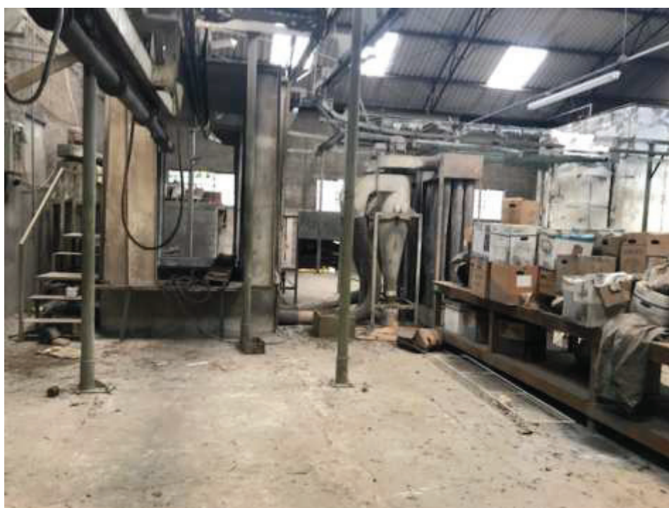
Foto 12 - Outra vista interna do superior do galpão principal.
