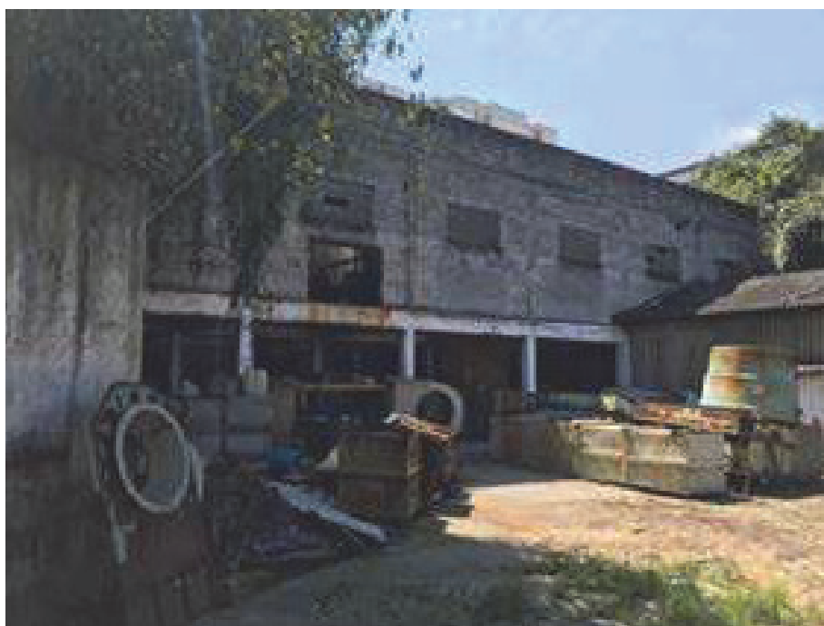
Foto 02 - Fachada interna do galpão principal.
