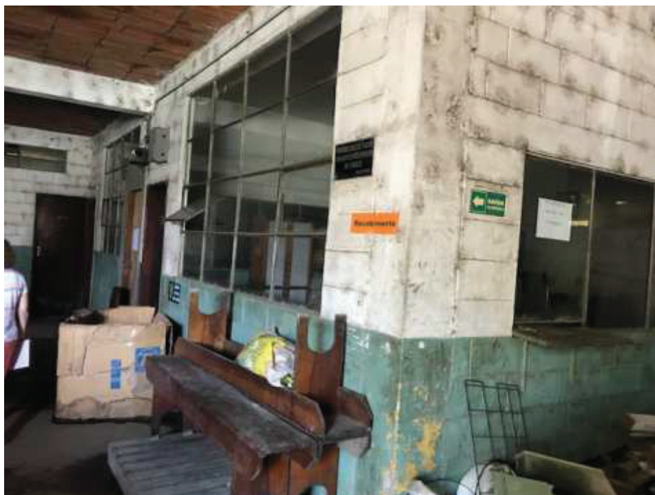
Foto 05 - Salas administrativas no térreo do galpão principal.
