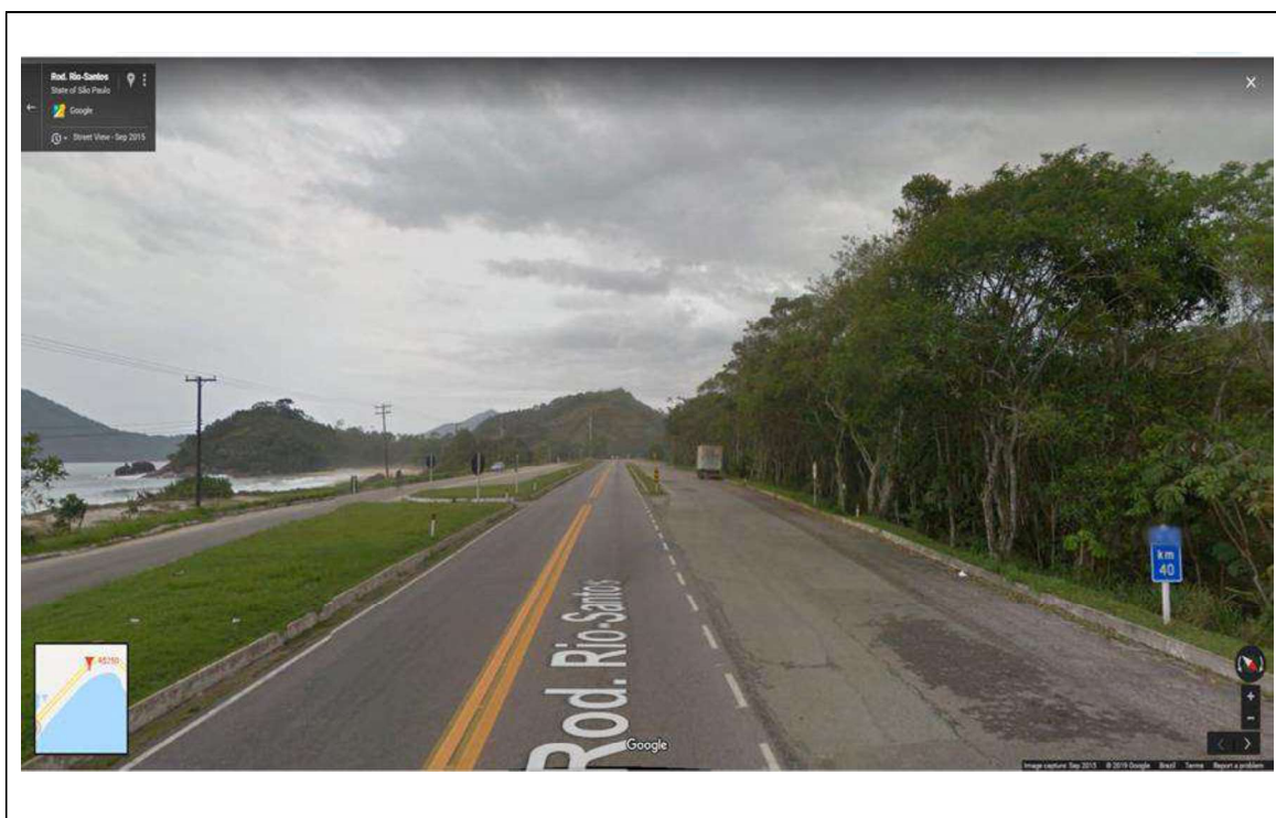
FOTO 01 – Vista geral do imóvel
