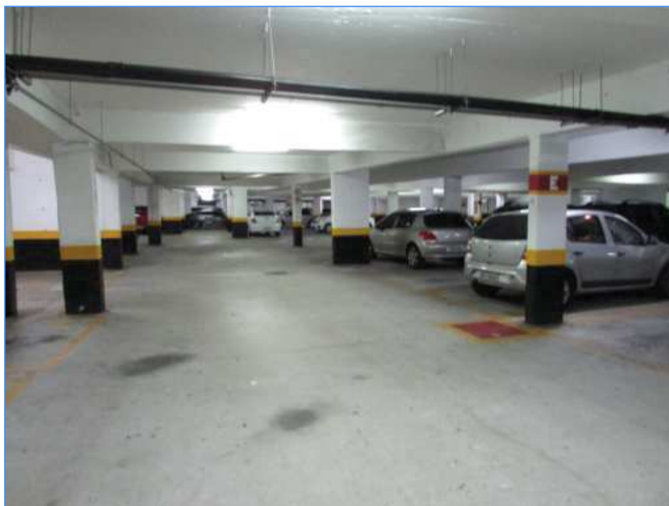
VAGAS DE ESTACIONAMENTO NOS SUBSOLOS.
