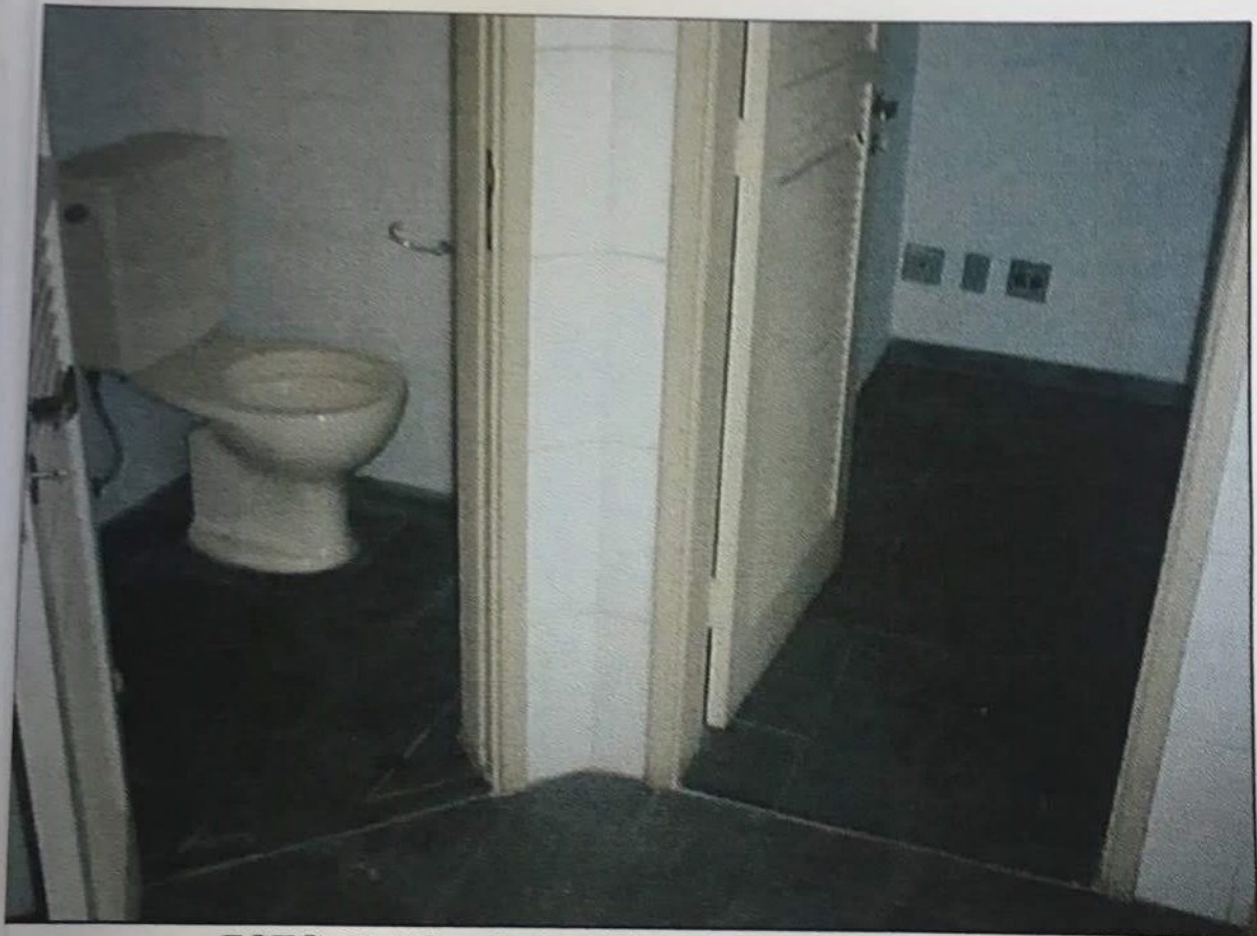
FOTO 07 - Vista do dormitório de empregada e do WC.
