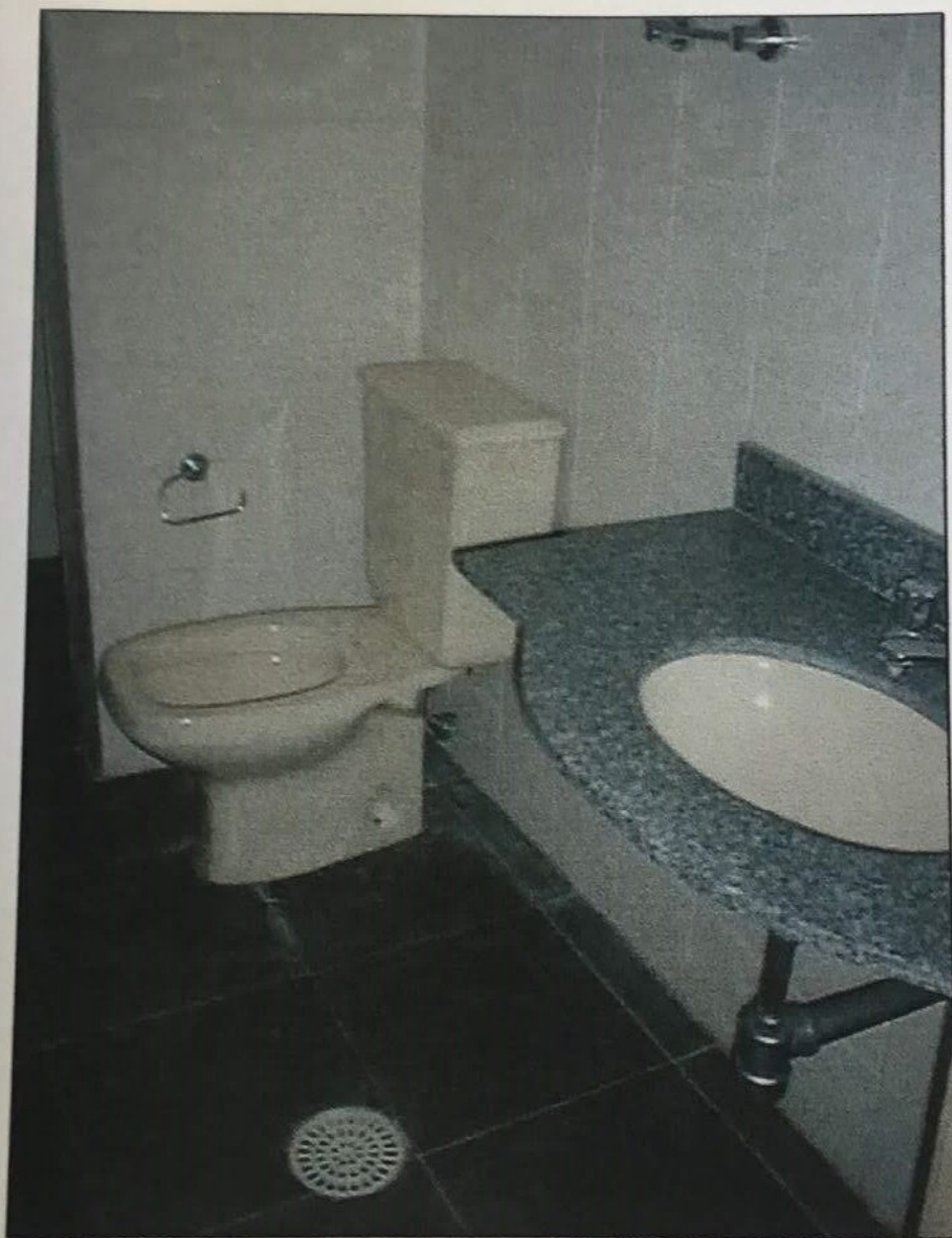
FOTO 05 - Vista do banheiro.
