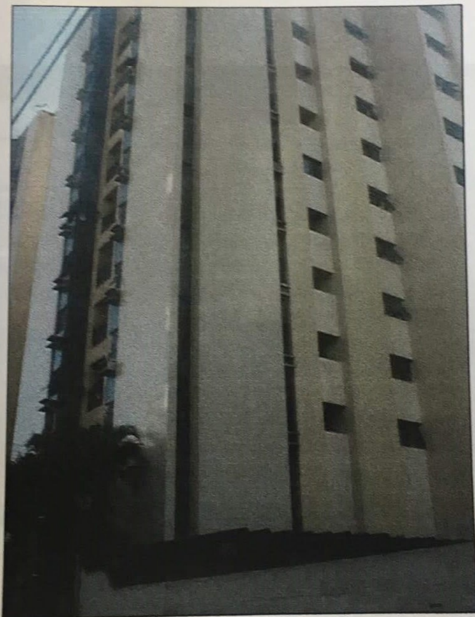
FOTO 02 – Vista da fachada do edifício onde localiza-se o apartamento avaliando.
