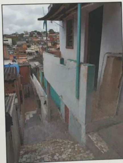
NOVA VISTA INTERNA DO IMÓVEL AVALIANDO
