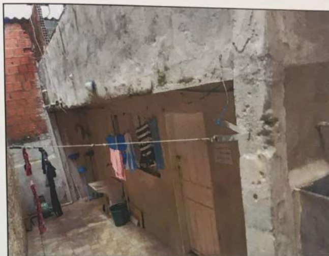
MAIS UMA VISTA INTERNA DO IMÓVEL AVALIANDO
