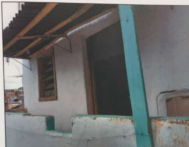
OUTRA VISTA INTERNA DO IMÓVEL AVALIANDO
