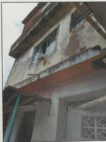
OUTRA VISTA INTERNA DO IMÓVEL AVALIANDO
