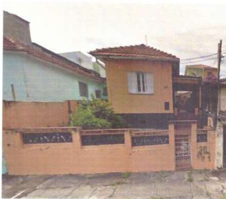
Fachada do Imóvel Avaliando
