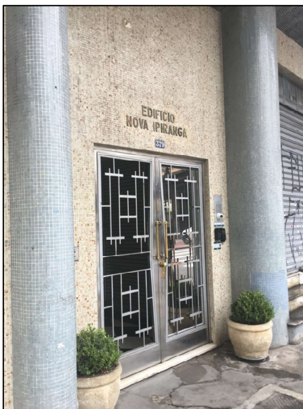
ASPECTOS GERAIS EDIFÍCIO
