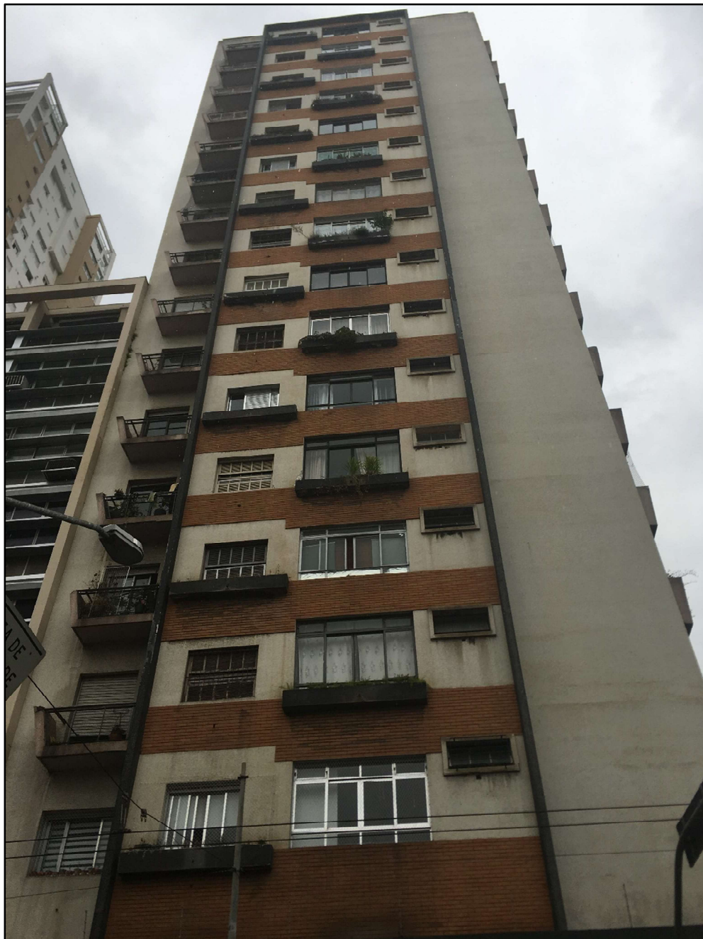
ASPECTOS GERAIS - EDIFÍCIO
