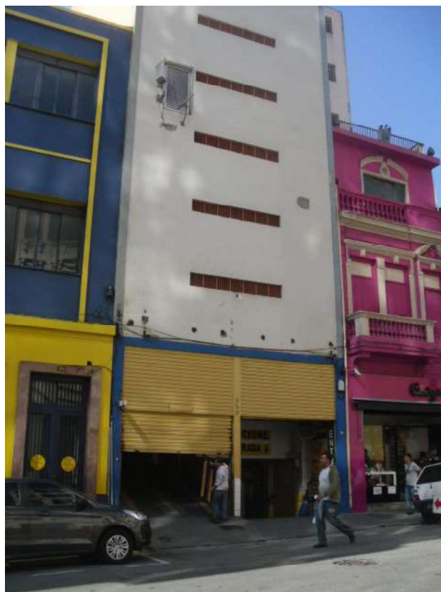
Foto 01 – Frente do edifício, Rua Florêncio de Abreu nº 282
