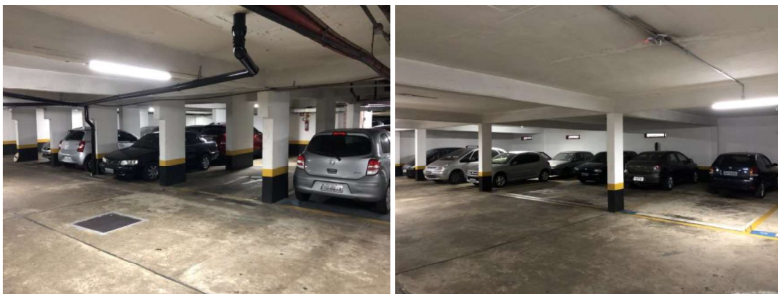
Imagem 4 - Vista geral do estacionamento da executada AWS Park.
