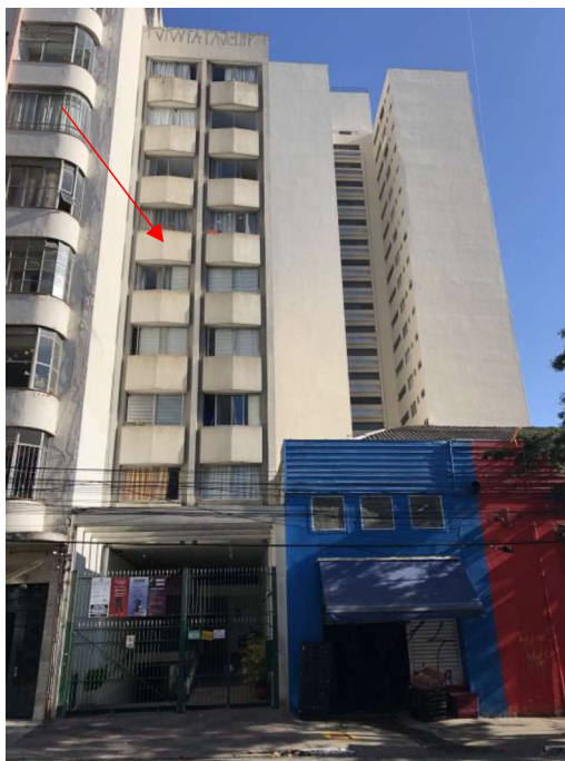
Imagem 6 - Vista da fachada do Cond. Ed. Larissa II, situado à Rua Martim Francisco, n. 58. Aos fundos, à direita, a fachada lateral do Ed. Larissa I.
