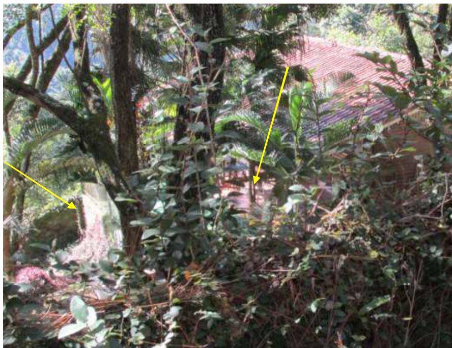
Foto 15) Outra vista da casa de madeira, agora visando a área de terraço e entorno. Observar desnível existente entre o nível piso da periferia da área da casa e, após, muro e gradil.
