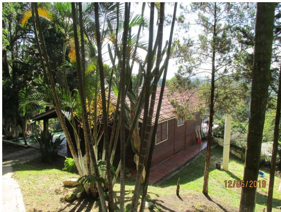
Foto 13) Vista da casa de madeira existente na porção central do terreno. Observar aparente bom estado de conservação.
