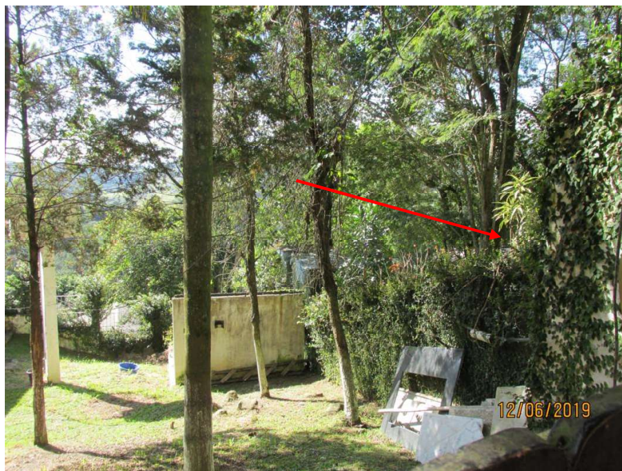
Foto 16) Vista da linha de divisa direita do terreno, com ênfase para o muro existente entre os lotes.
