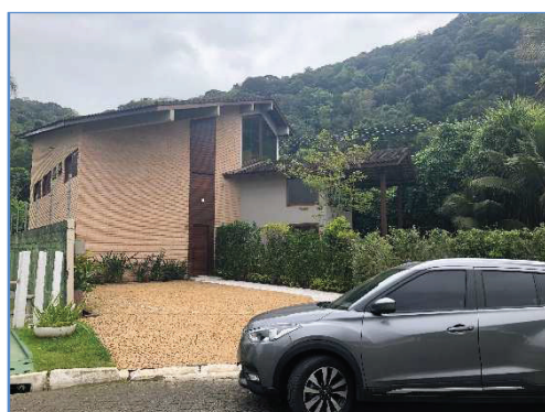
Foto 17 – Vista da fachada frontal
