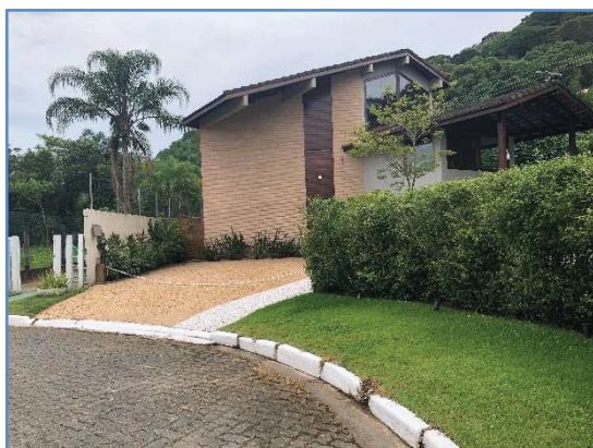
Foto 13 – Vista da fachada frontal do imóvel
