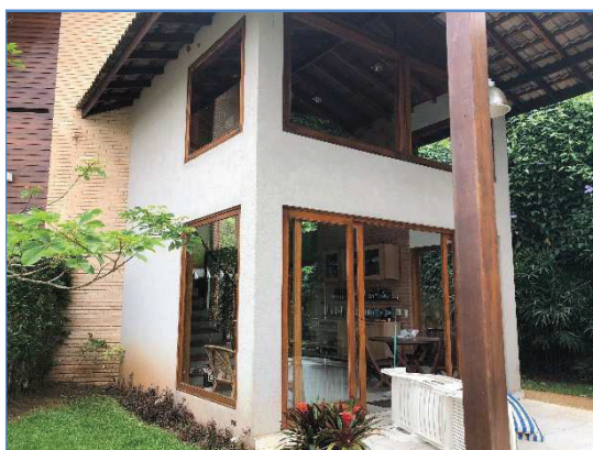
Foto 16 – Vista da fachada frontal
