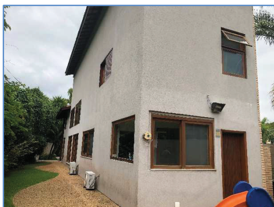
Foto 9 – Vista da fachada de fundos e lateral do imóvel
