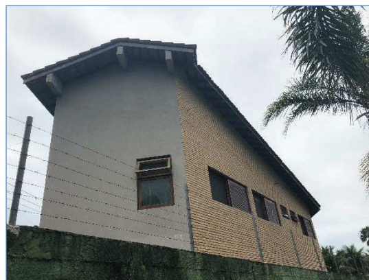
Foto 12 – Vista das fachadas laterais e de fundos
