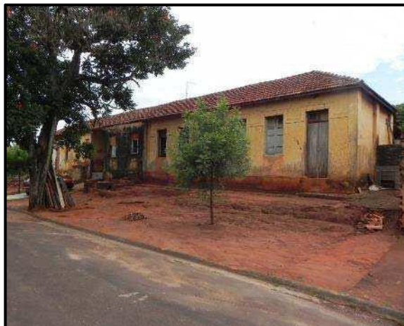
Vista parcial da fachada do imóvel
