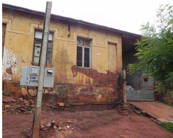
Vista parcial da fachada do imóvel
