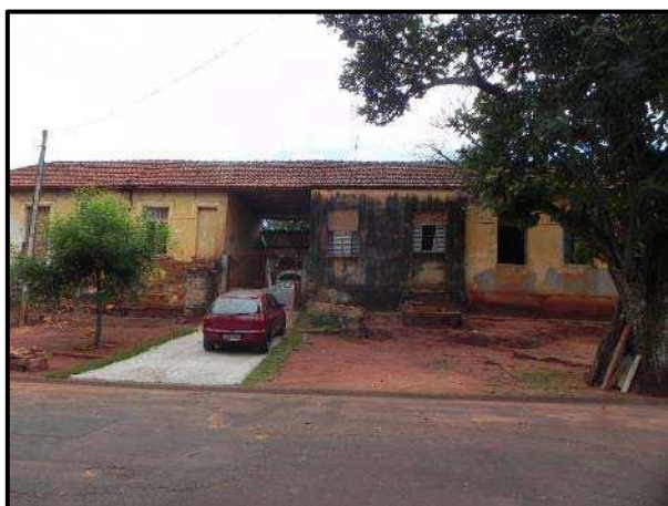
Vista parcial externa do imóvel
