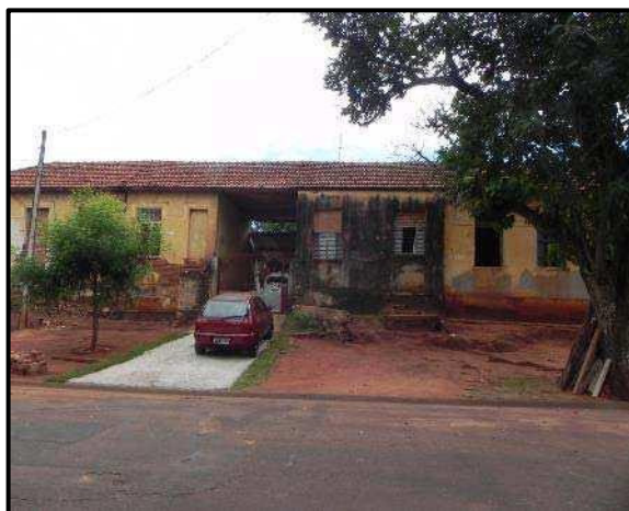
Vista parcial da fachada do imóvel
