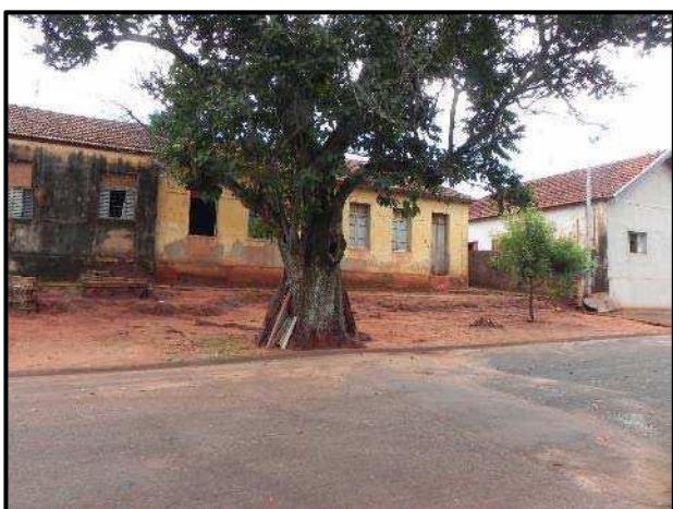
Vista parcial da fachada do imóvel
