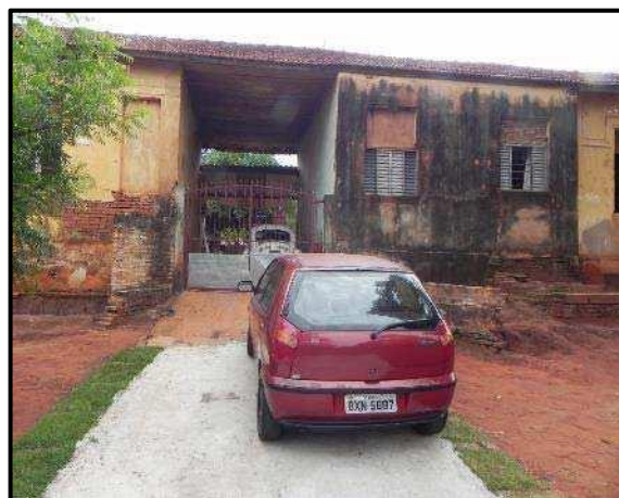
Vista parcial da fachada do imóvel
