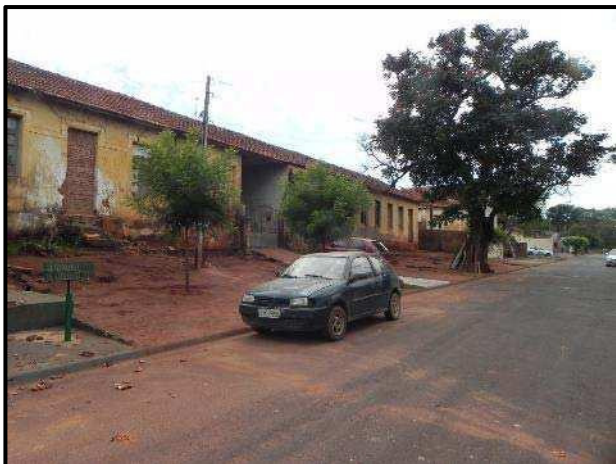
Vista parcial da fachada do imóvel
