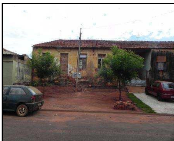
Vista parcial da fachada do imóvel
