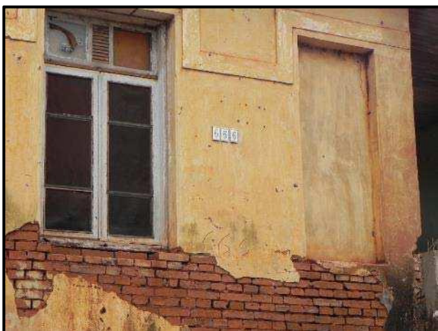
Vista parcial da fachada do imóvel
