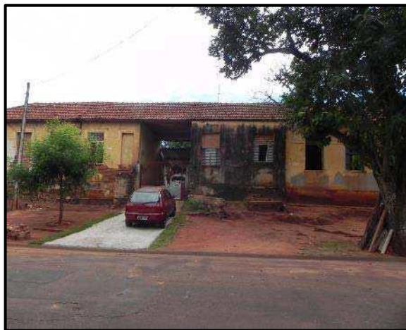
Vista parcial da fachada do imóvel
