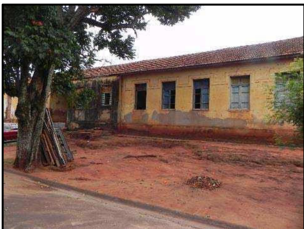
Vista parcial da fachada do imóvel
