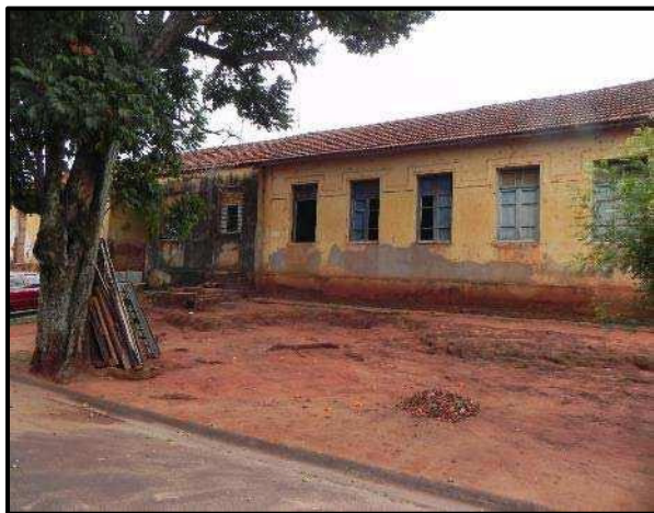
Vista parcial da fachada do imóvel
