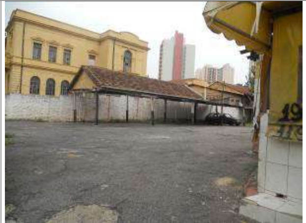
Vista parcial interna do imóvel
