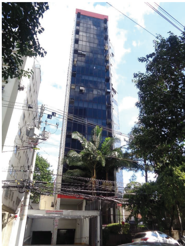
Figura 3. Fachada do prédio.
