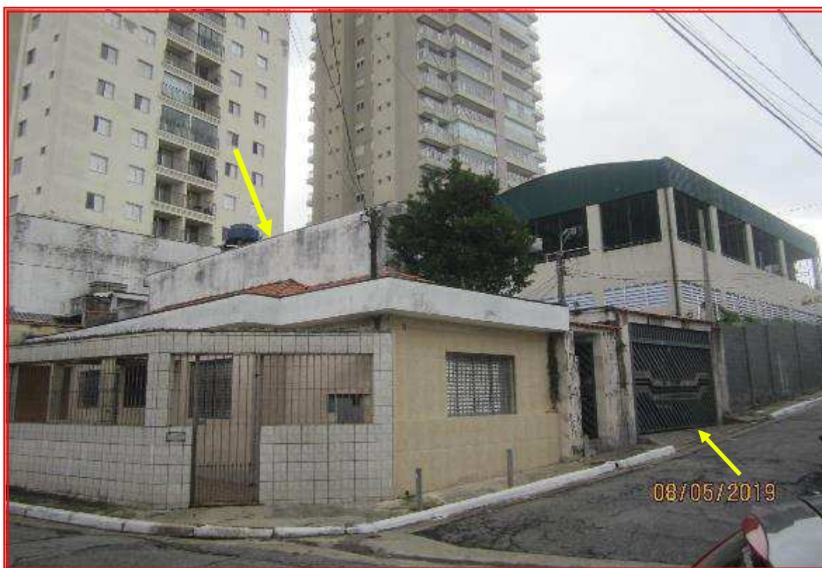
Foto nº 03: Vista geral da fachada frontal e lateral do imóvel avaliando.
