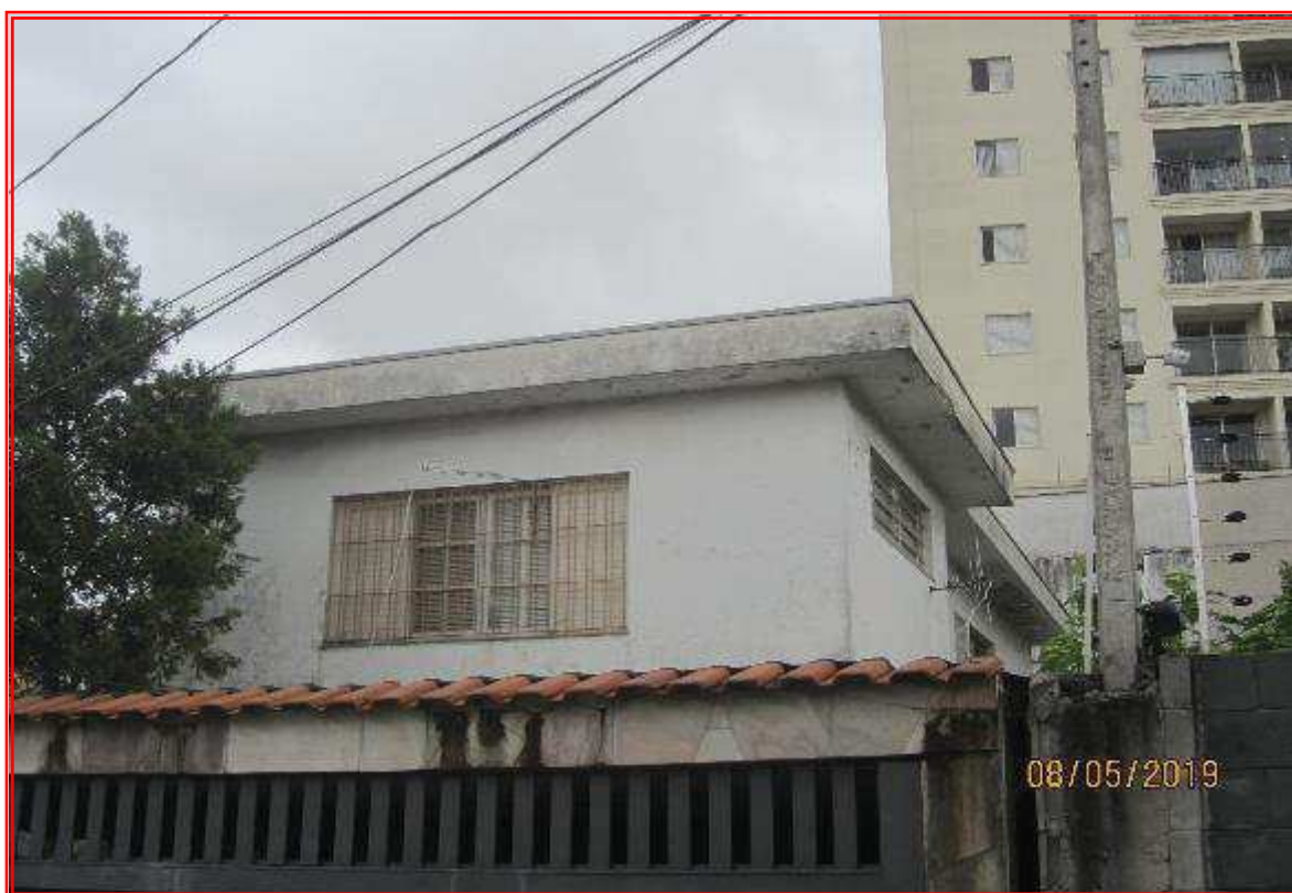
Foto nº 07: Vista geral das fachadas frontal e lateral do pavimento superior.
