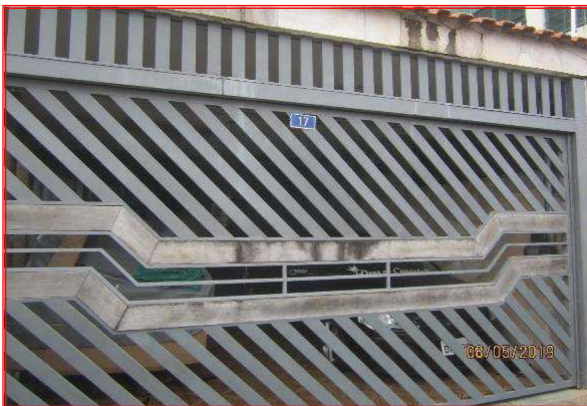
Foto nº 06: Detalhe para a identificação oficial de logradouro, sob nº 17 da Rua Mello Mattos.
