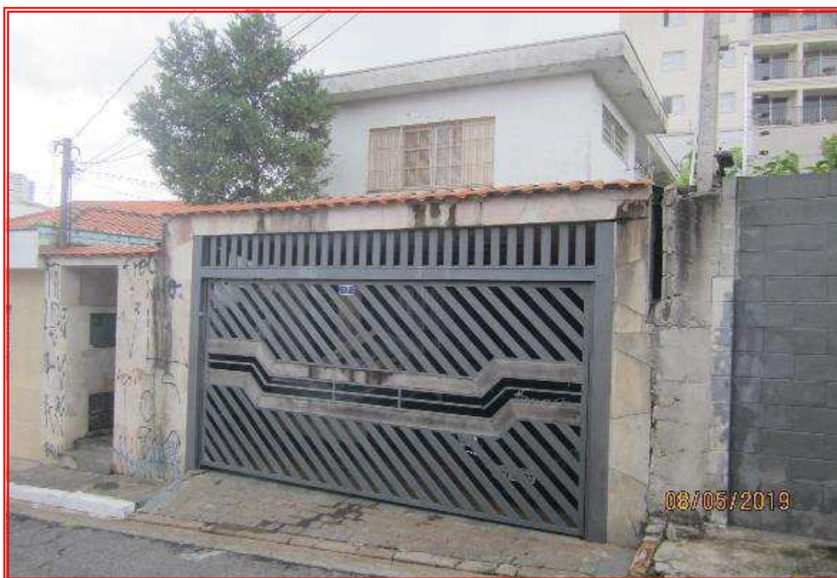
Foto nº 05: Outra vista geral da fachada da edificação, com detalhe para a garagem frontal e pavimento superior do corpo principal.
