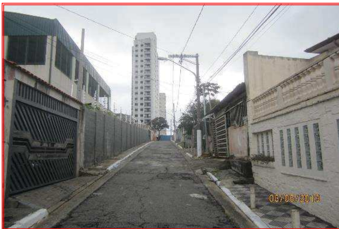
Foto nº 02: Vista parcial da Rua Mello Mattos, tomada no sentido oposto.
