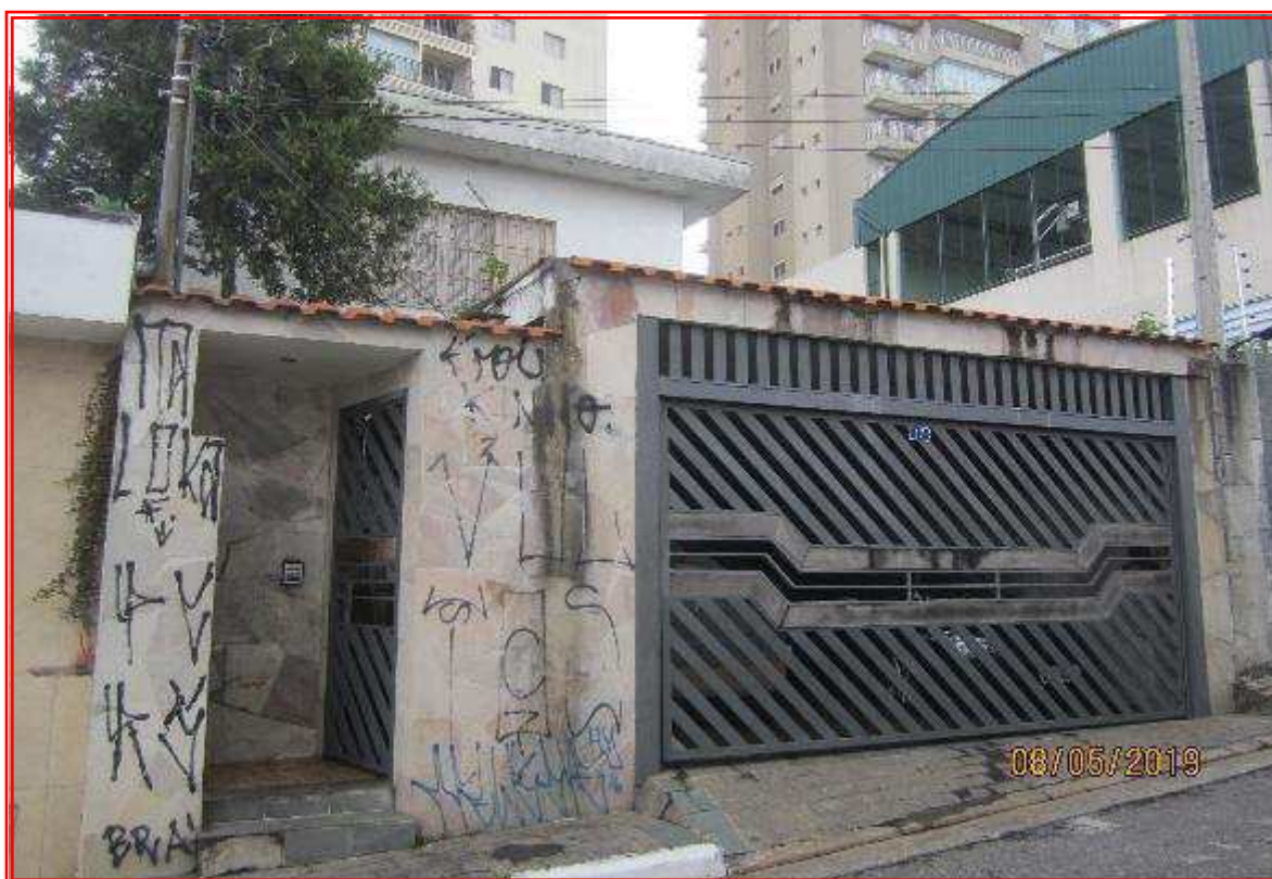
Foto nº 04: Vista geral da fachada frontal do imóvel avaliando.
