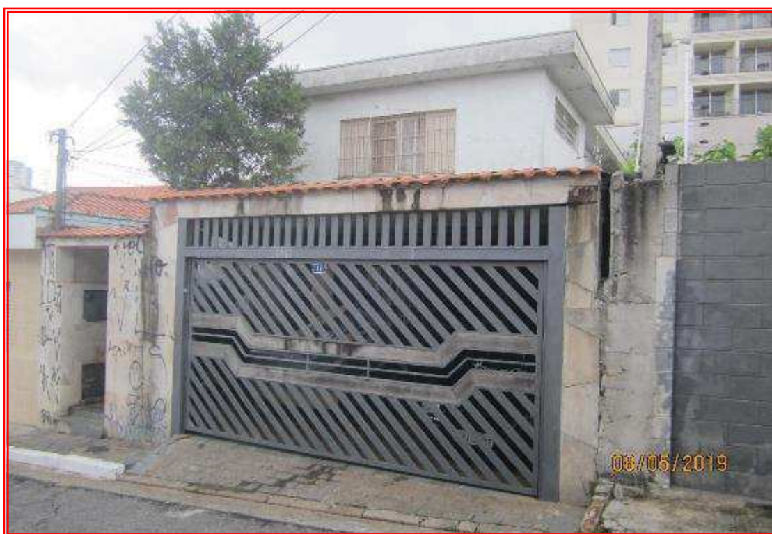
Foto: Vista geral da fachada do imóvel, objeto da avaliação.
