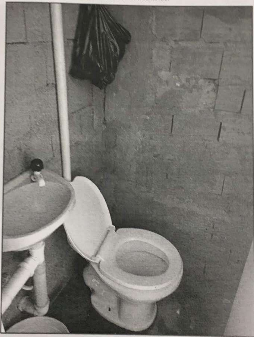
Foto 7 - Vista geral do Sanitário 2 do imóvel avaliando.
