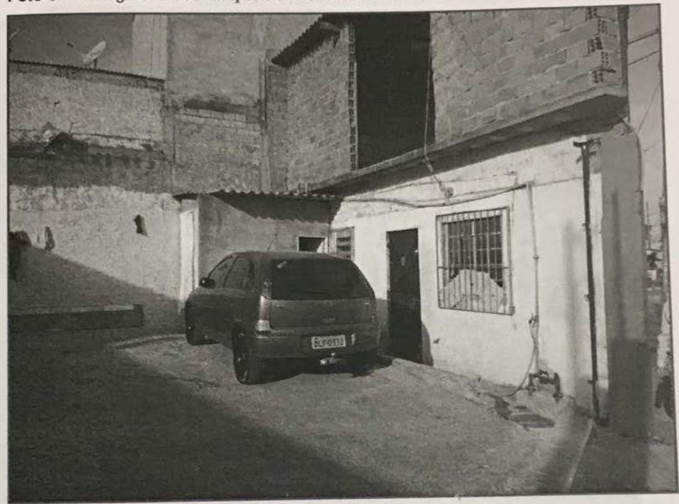
Foto 5 - Vista geral da edificação do imóvel avaliando.
