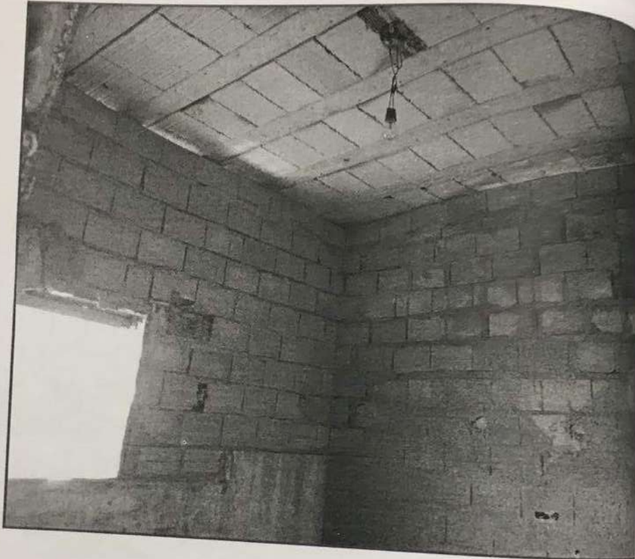
Foto 10 - Vista geral do teto do Quarto do dormitório avaliando.
