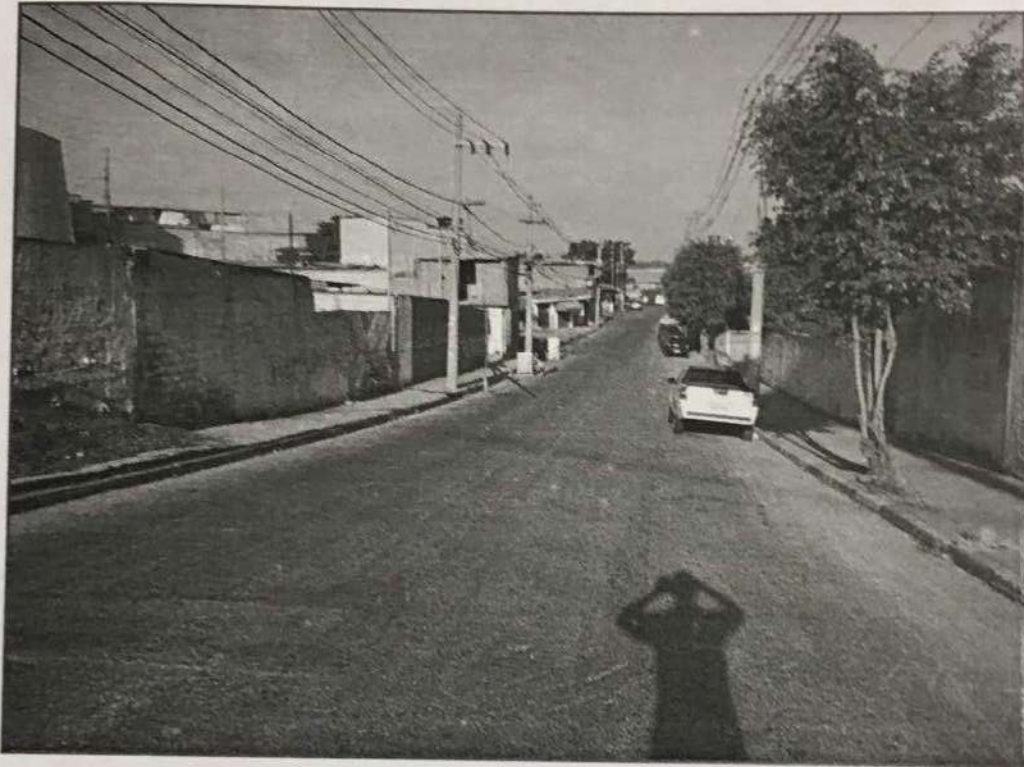
Foto 1 – Vista geral da Rua Campo Grande, que dá acesso ao imóvel avaliando, indicado pela seta vermelha.
