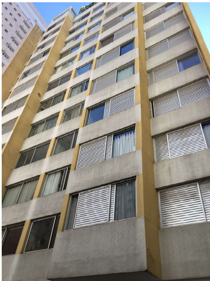
ASPECTOS FACHADA DO EDIFÍCIO
