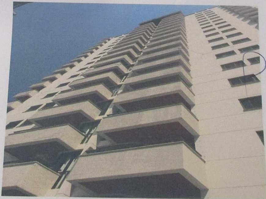
Vista da fachada do edifício.
