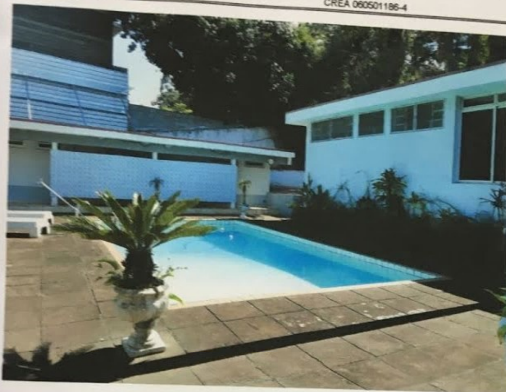
FOTO 05 - Vista da piscina.
