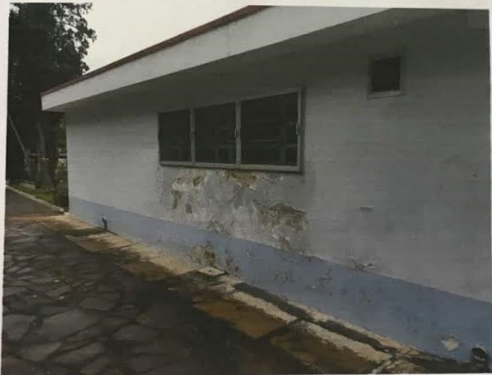
Detalhe do local mostrado na foto anterior.
