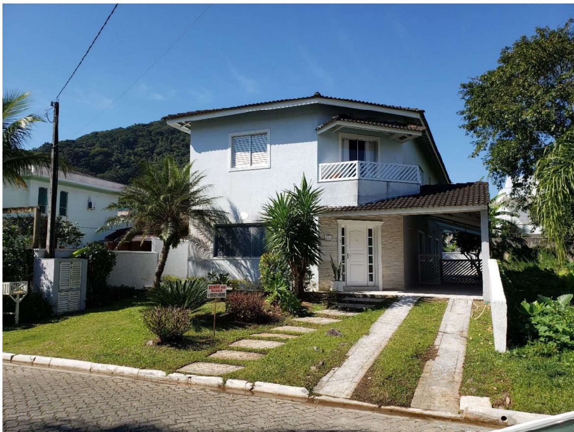
Foto 1 – Fachada do Edificação
