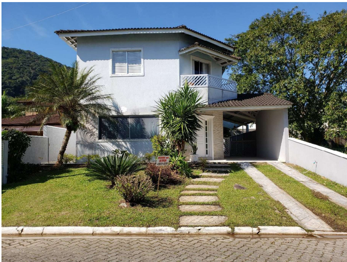
Foto 2 – Fachada do Edificação
