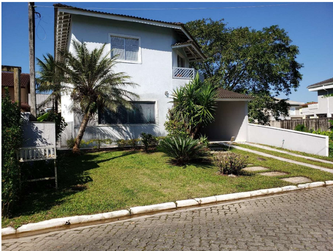
Foto 3 – Fachada do Edificação
