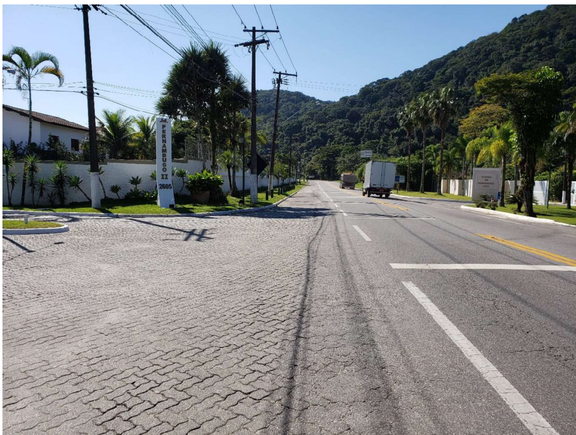
Foto 9 – Acesso da Rodovia ao condomínio
