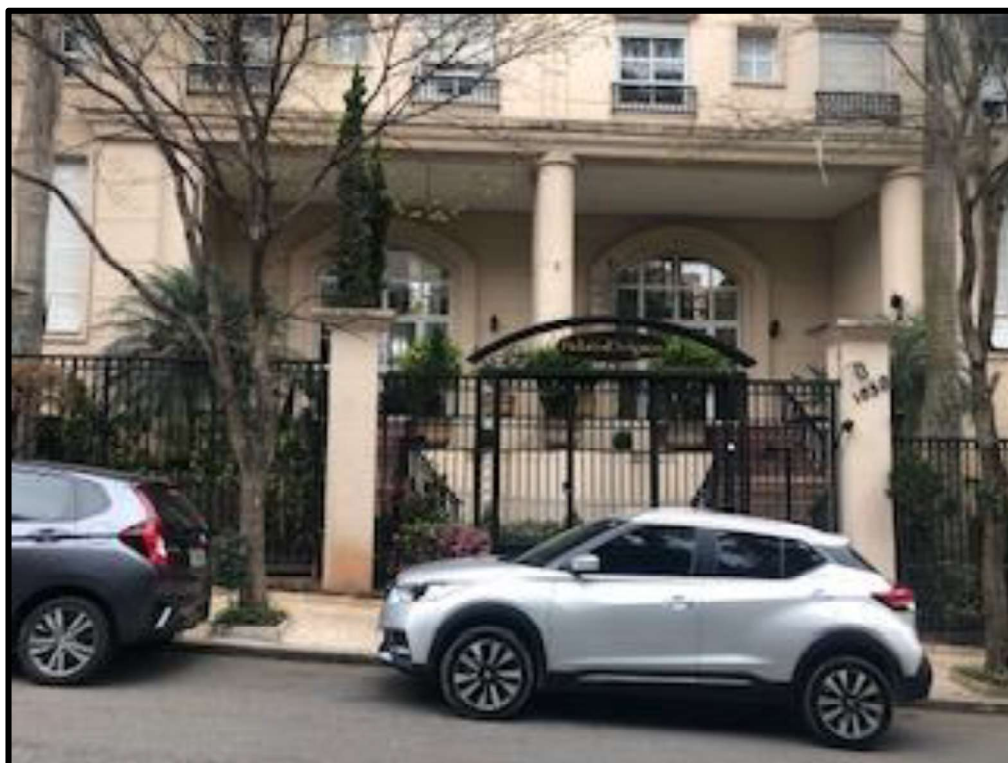
Foto 2: Edifício Palais D'Avignon
