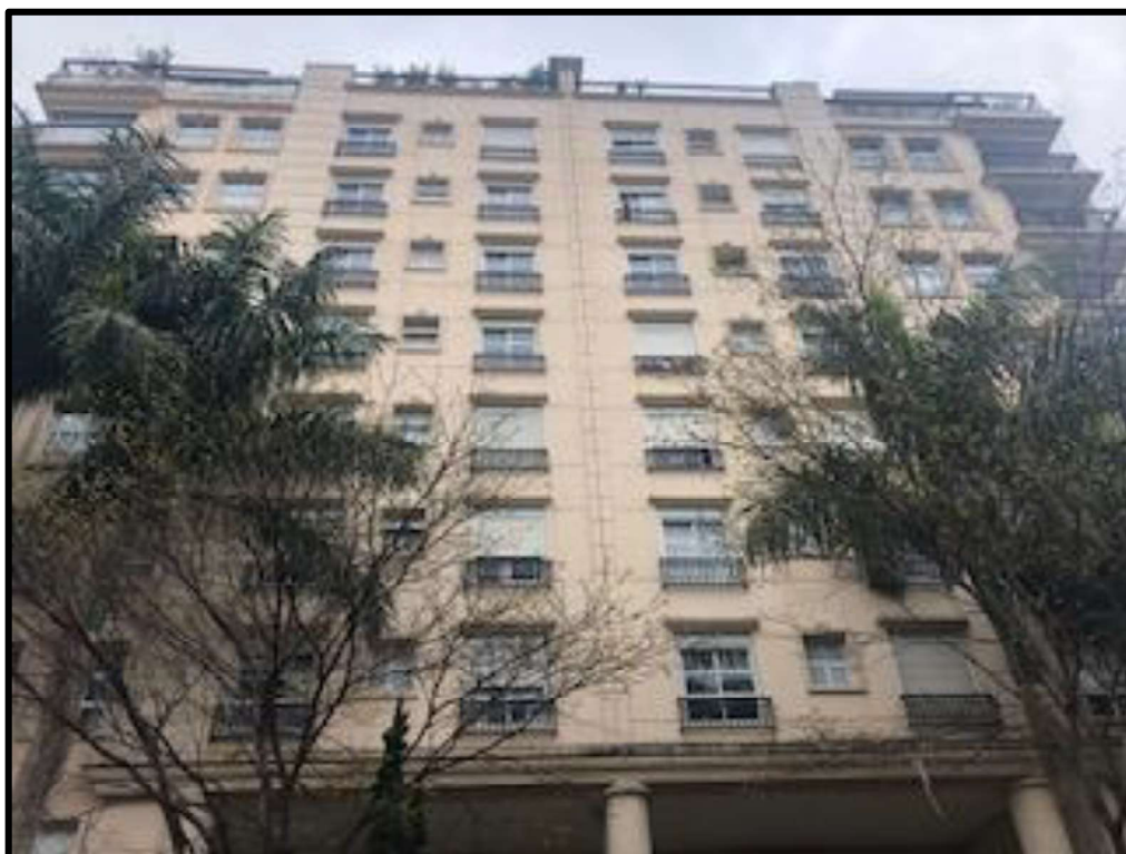
Foto 4: Edifício Palais D'Avignon
