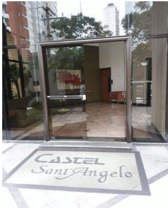
FOTO Nº 02 VISTA PARCIAL ENTRADA DO EDIFÍCIO
