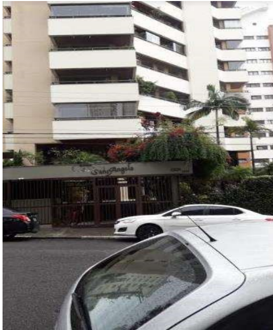
FOTO Nº 01 VISTA PARCIAL FACHADA
