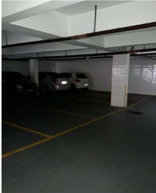
FOTO Nº 07 VISTA PARCIAL GARAGEM
