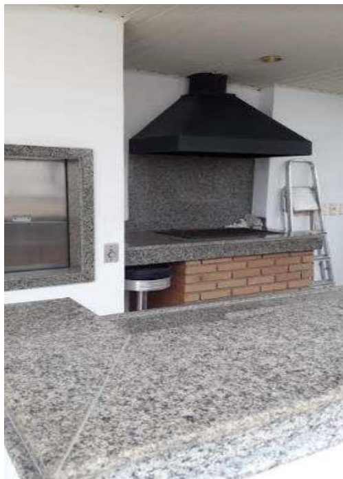
FOTO Nº 28 VISTA PARCIAL CHURRASQUEIRA – ELEVADOR DE BEBIDAS PAVIMENTO SUPERIO
