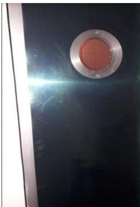
FOTO Nº 30 VISTA PARCIAL SAUNA (PAVIMENTO SUPERIOR)
