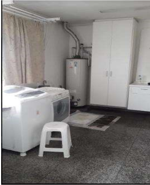
FOTO Nº 19 VISTA PARCIAL ÁREA DE SERVIÇO
