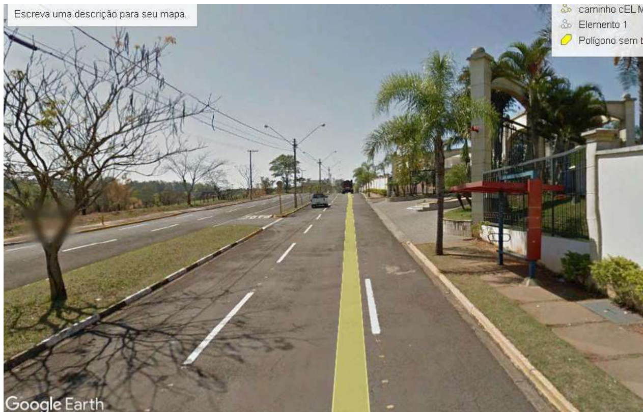
VISTA PARCIAL DA AV. CEL JOSE SOARES MARCONDES - FONTE GOOGE EARTH
