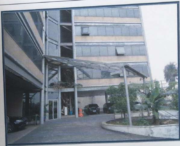
Vista do prédio.
