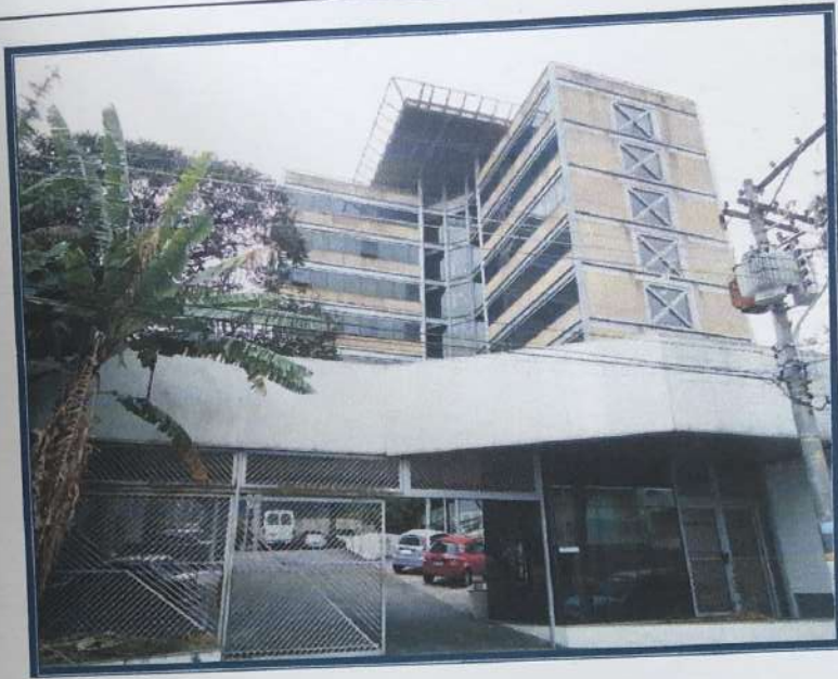
Vista do prédio.
