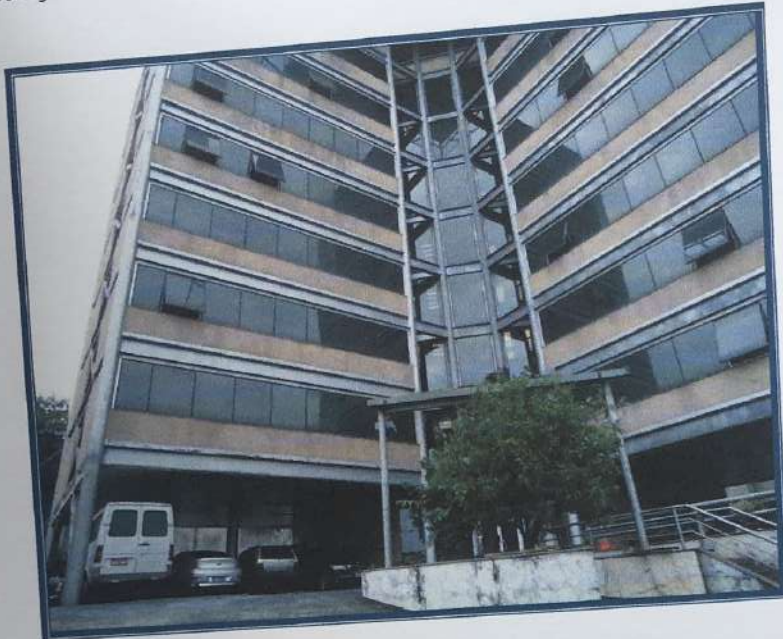
Vista do prédio.
