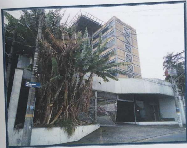
Vista da frente do imóvel avaliando.
