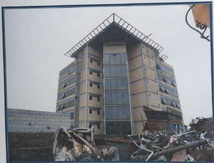
Vista do prédio.
