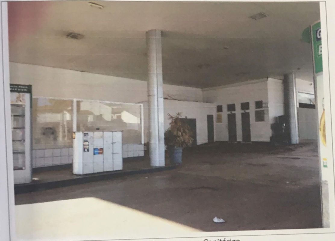
Foto 02 – Vista ao fundo da Casa do Compressor e Sanitários
