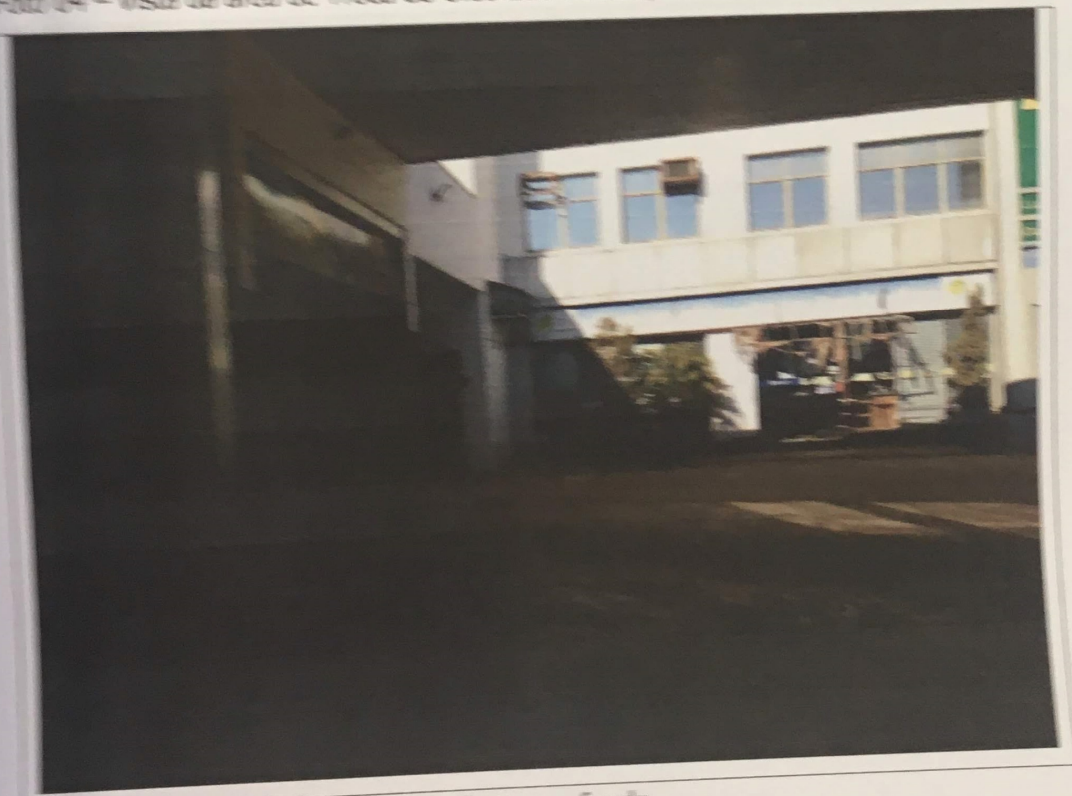
Foto 05 - Vista da Loja de Conveniências ao fundo
