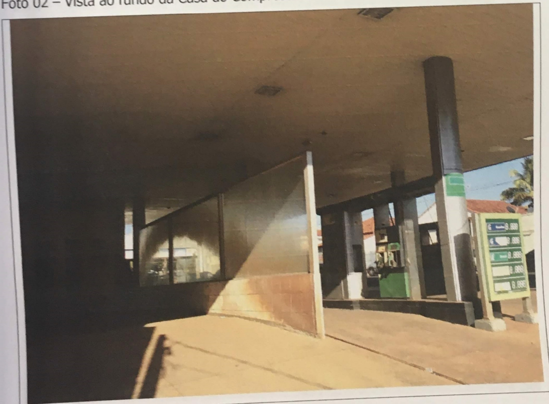
Foto 03 – Vista da área de Lavagem de Veículos
