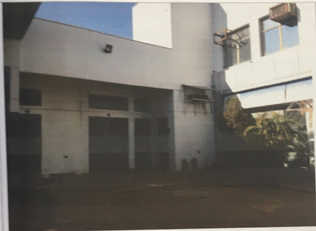
Foto 06 – Vista das portas do Depósito, Copa e Escada de acesso ao 2º pavimento
