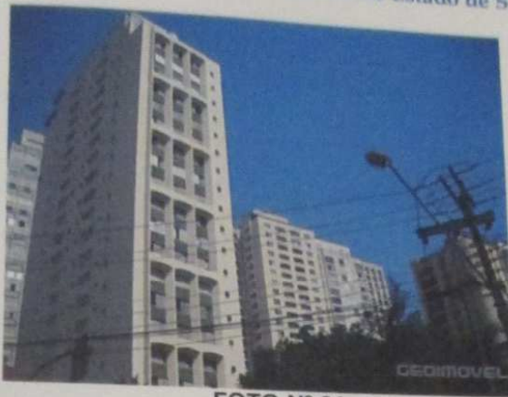
FOTO N° 01 Vista parcial fachada Conjunto Praça dos Franceses
